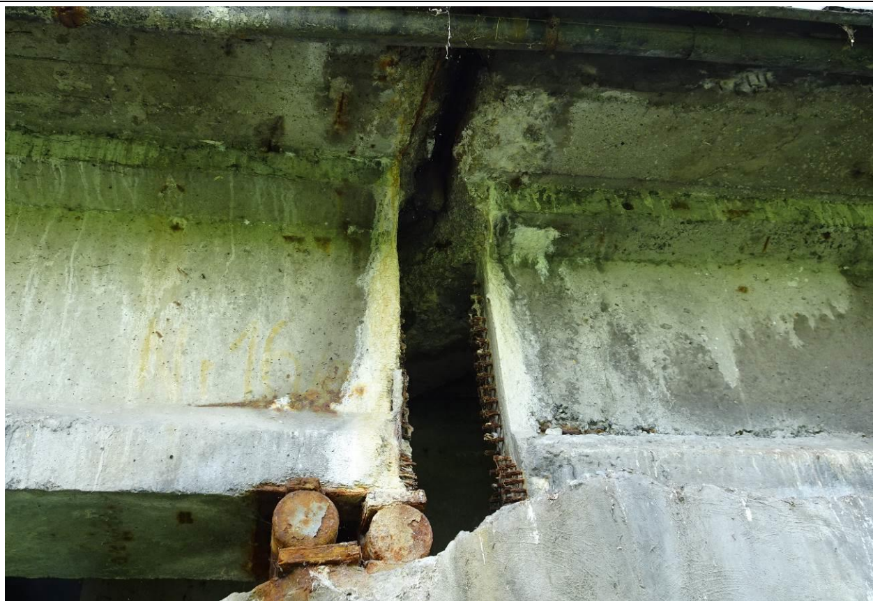
Fot. 24. Korozja betonu i zbrojenia płyty pomostu i belek skrajnych od GW nad podporą P-3 spowodowana przeciekami przez dylatację. Zdublowane, niewłaściwie ustawione, skorodowane łożyska wałkowe.
