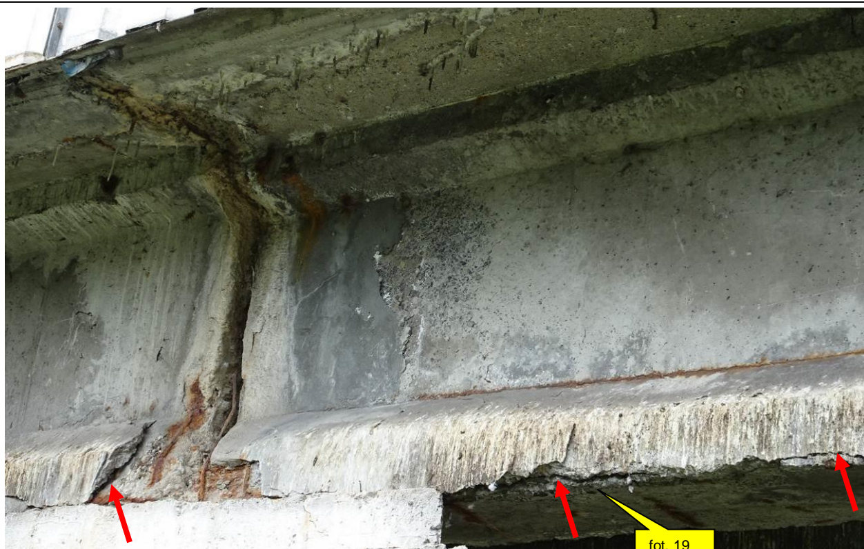
Fot. 18. Uszkodzenia belek skrajnych od DW nad podporą P-2. Spękania betonu w półkach dolnych belek spowodowane intensywną korozją zbrojenia (również sprężającego). Uszkodzenia spowodowane przeciekami przez dylatację. Widoczne przecieki i korozja betonu w płycie pomostu.
