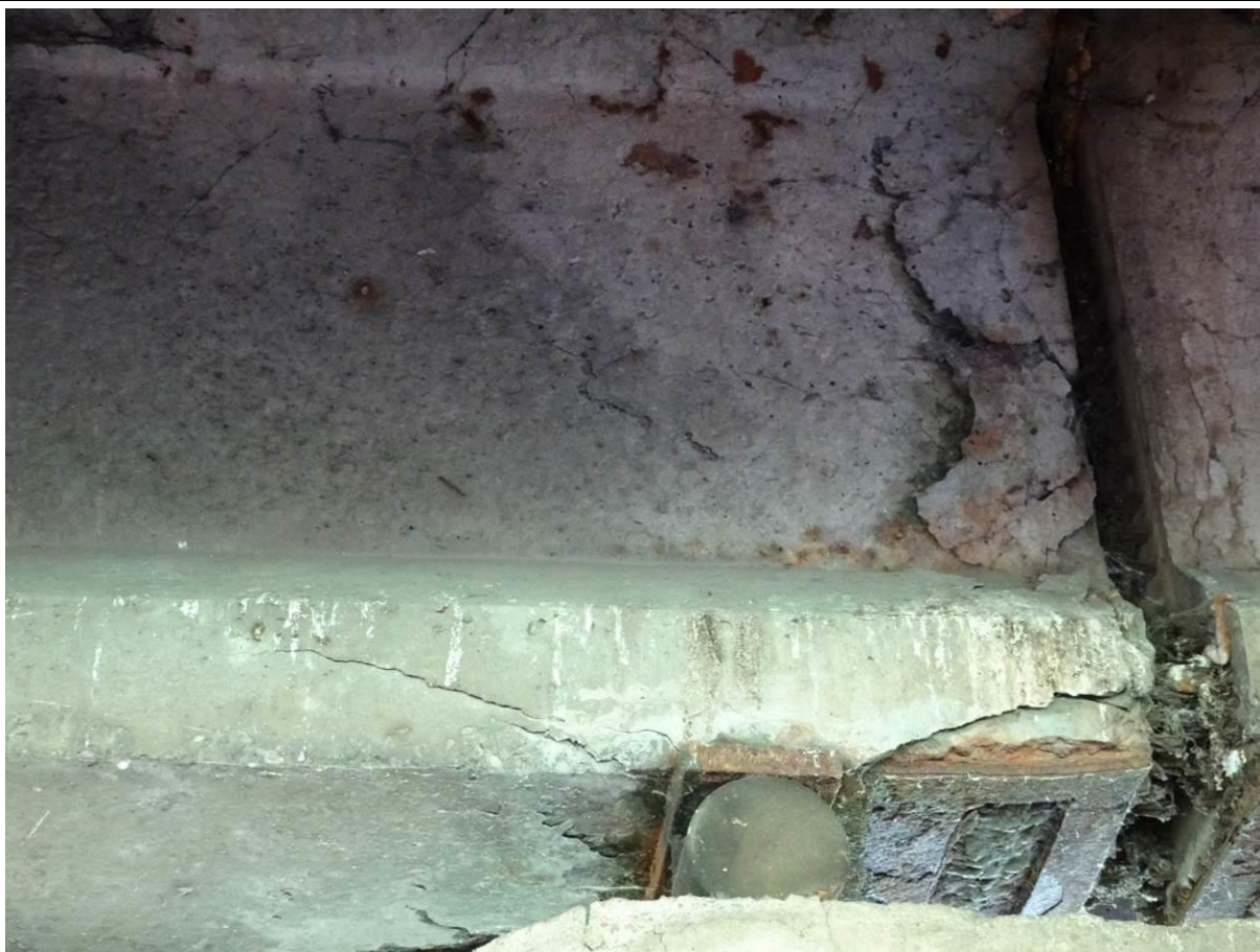
Fot. 25b. Przęsło 3, belka nr 6 nad podporą P-3. Spękania i odpryski otuliny spowodowane korozją zbrojenia w następstwie przecieków przez dylatację.
