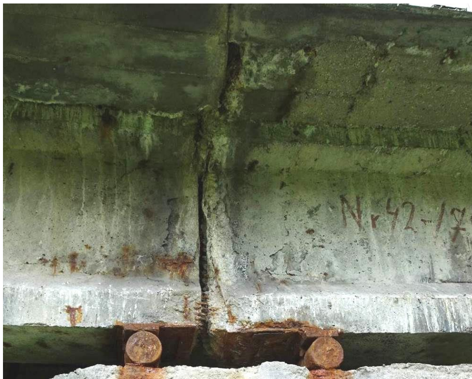
Fot. 26b. Uszkodzenia belek skrajnych od DW nad podporą P-3. Intensywna korozja betonu i zbrojenia oraz spękania i odpryski otuliny. Korozja łożysk wałkowych i blach nadłożyskowych. Uszkodzenia spowodowane przeciekami przez dylatację.
