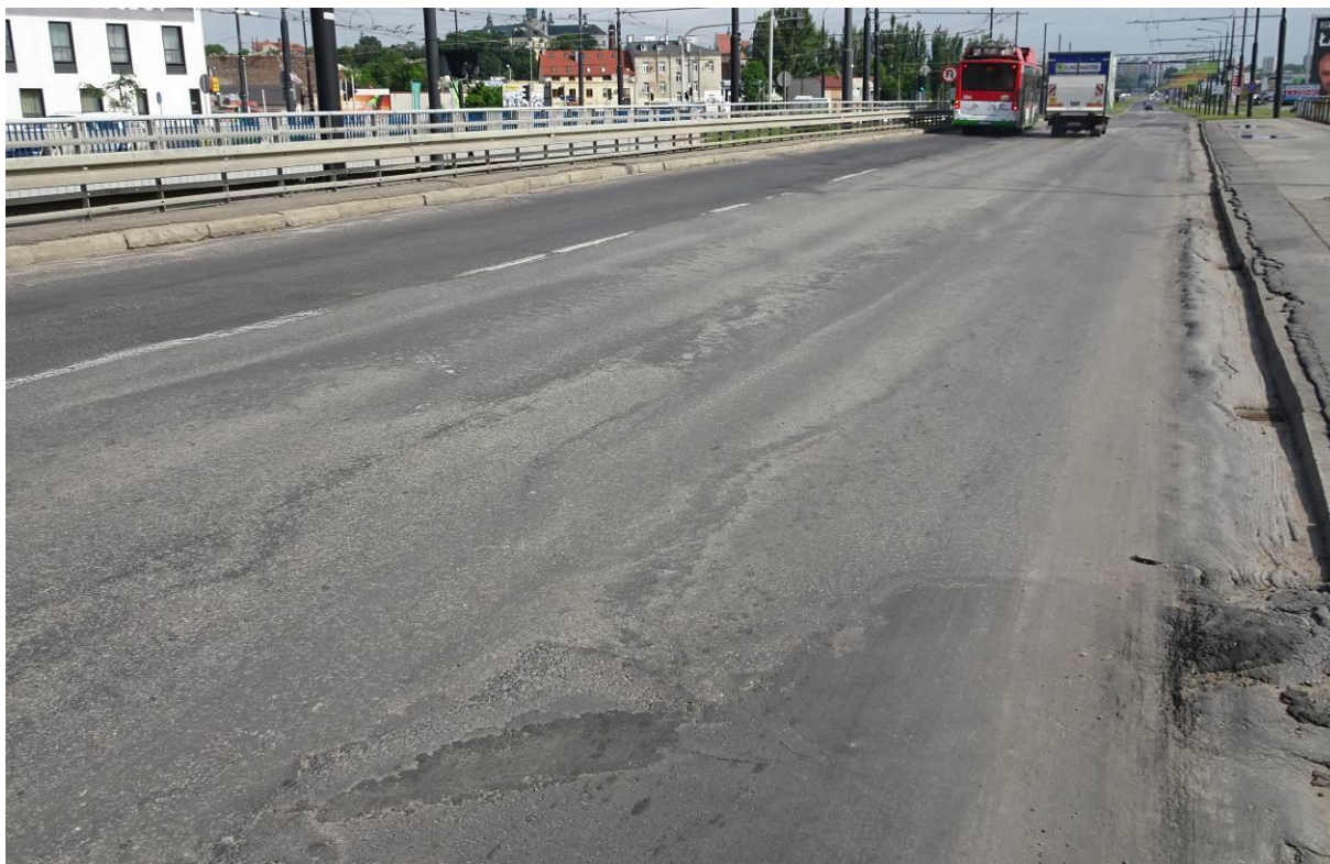
Fot. 11. Widok ogólny nawierzchni jezdni. Na całej powierzchni koleiny o głębokości do 5 cm. Przy krawężniku głębokość koleiny sięga 10 cm, blokując możliwość spływu wody do krtek ściekowych.
