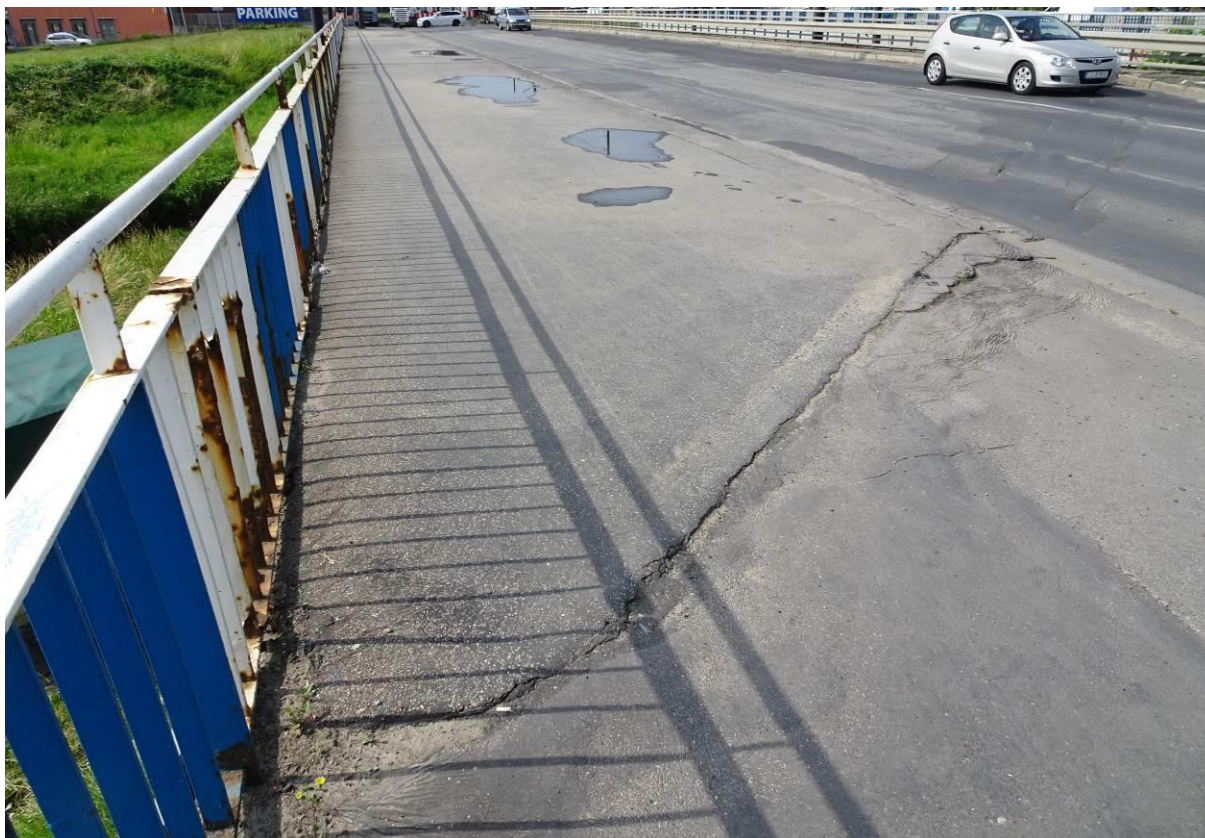
Fot. 15. Widok wzdłuż chodnika od DW. Niewielkie deformacje nawierzchni i brak spadku poprzecznego powodujące utrzymywanie się zastoisk wody. Spękania nawierzchni nad dylatacją spowodowane osiadaniem dojazdu. Intensywna korozja balustrady.
