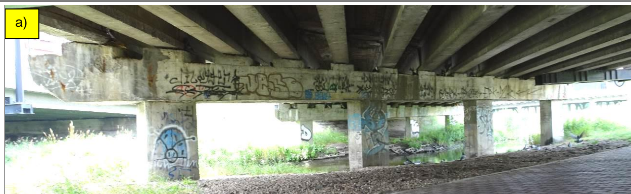
Fot. 37. Podpora P-4, widok od str. DW (fot. a) i od str. GW (fot. b). Zawilgocenie i korozja betonu w ścianie zapleczonej i w belkach spowodowane przeciekami przez dylatację. Korozja łożysk stycznych. Wegetacja roślinna na stożkach powodująca zacinienie skrzydeł.
