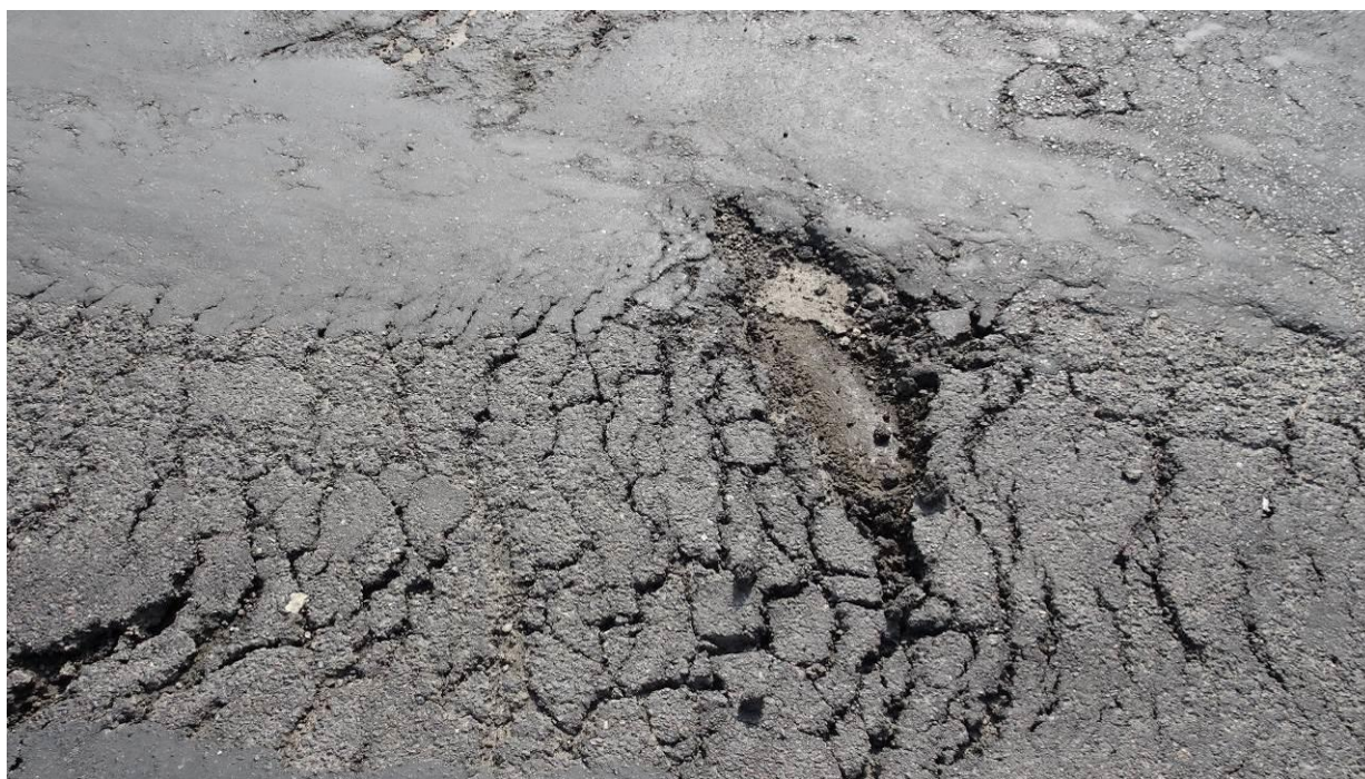
Fot. 14. Szczegół uszkodzeń nawierzchni – widoczna uszkodzona izolacja papowa.
