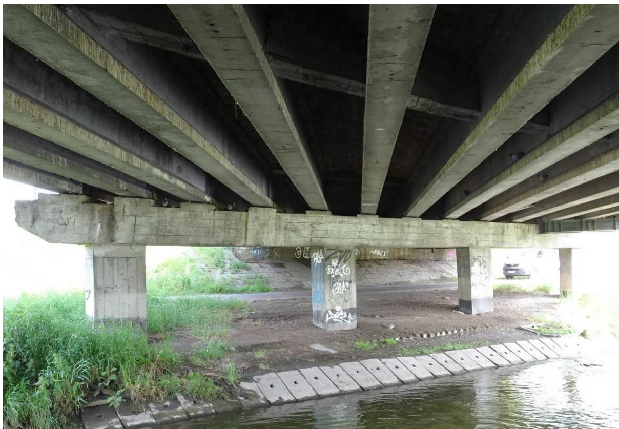
Fot. 5. Widok spodu konstrukcji przęsła oraz filara prawobrzeżnego (podpora L-2)
