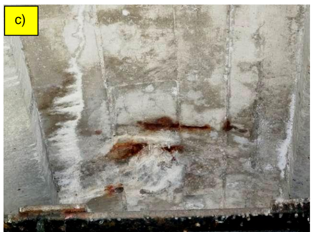
Fot. 16. Przęsło nr 1. Przecieki przez płytę pomostu: a) na wsporniku lewym, b) pomiędzy belką nr 12 i 13, c) pomiędzy belką 11 i 12 (numeracja belek wg rys. 2.1).
