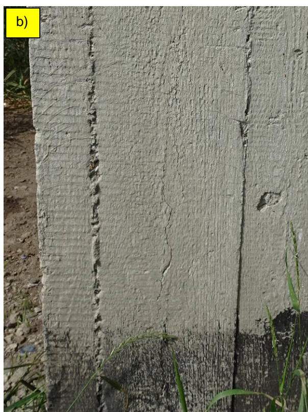
Fot. 44. Podpora L-2. Zarysowania pionowe w słupach spowodowane korozją zbrojenia: a) słup skrajny od GW; b) słup skrajny od DW.
