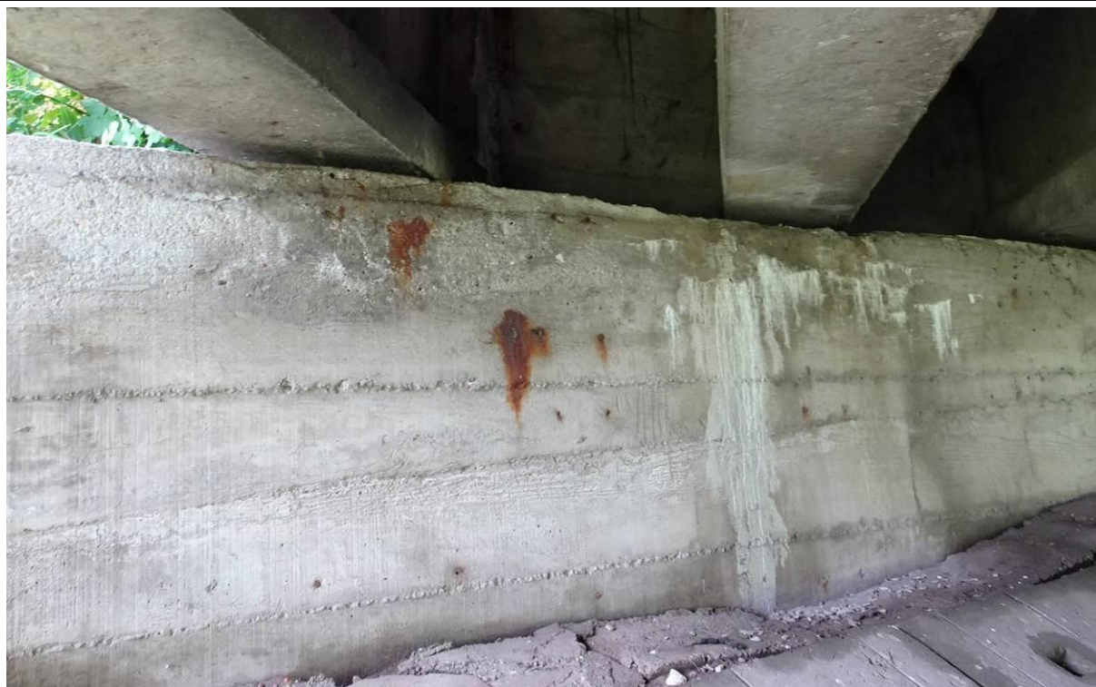
Fot. 36a. Podpora P-4. Zarysowania z przeciekami i intensywna korozja betonu. Punktowa korozja zbrojenia. Uszkodzenia spowodowane przeciekami przez dylatację.
