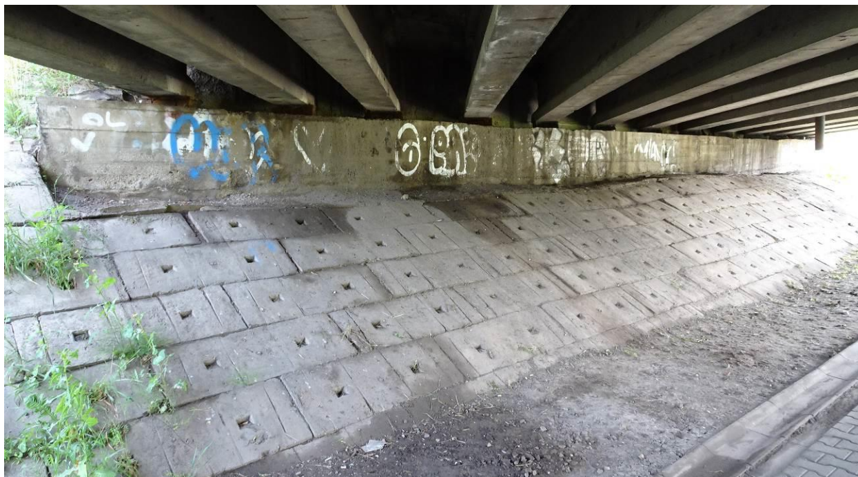
Fot. 29. Podpora L-1, widok ogólny. Powierzchniowe ubytki betonu w ścianie czołowej i ścianie zapleczej spowodowane niską jakością betonu i błędami wykonawczymi. Trzy rysy pionowe o rozwarości do 0,5 mm. Zanieczyszczenie betonu w wyniku zacieków z dylatacji. Niewielka deformacja betonowego umocnienia skarpy spowodowana osiadaniem gruntu. Szczegóły uszkodzeń pokazano na kolejnych fotografiach i na rys. 2.2.1.
