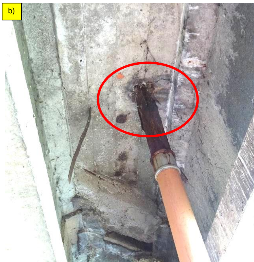
Fot. 53. Uszkodzenia elementów odwodnienia: a) przykład niedrożnego wpustu – widoczna zamulona kratka ściekowa; b) dziurawa stalowa rura spustowa.
