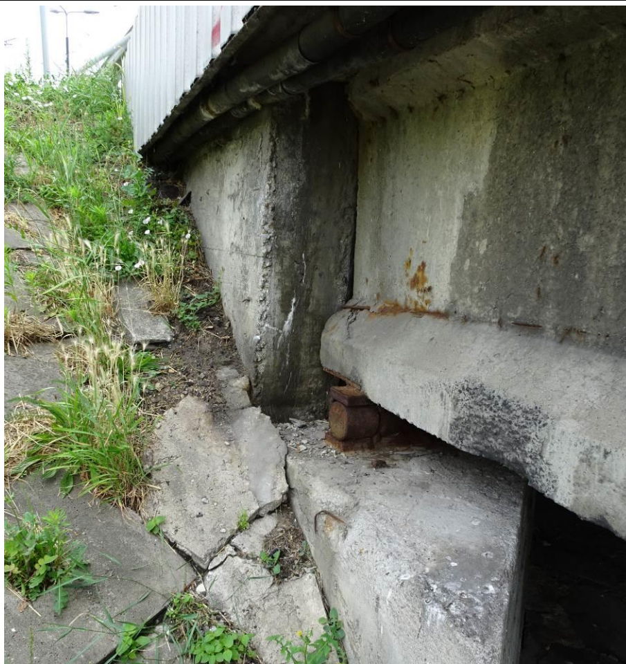
Fot. 33. Podpora P-1, widok od GW. Zawilgocenie i wykwyty na ścianie zapleczej. Korozja łożyska wałkowego. Niewielkie deformacje umocnienia stożka. Widoczna również korozja zbrojenia w środku belki.
