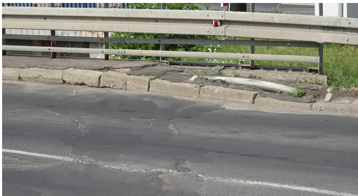
Fot. 8. Zaniżenie nawierzchni dojazdu nad podporą L-1 o ok. 10 cm spowodowane osiadaniami. Deformacje krawężnika i nawierzchni opaski powodujące odsłonięcie rury osłonowej przebiegającej w opasce.
