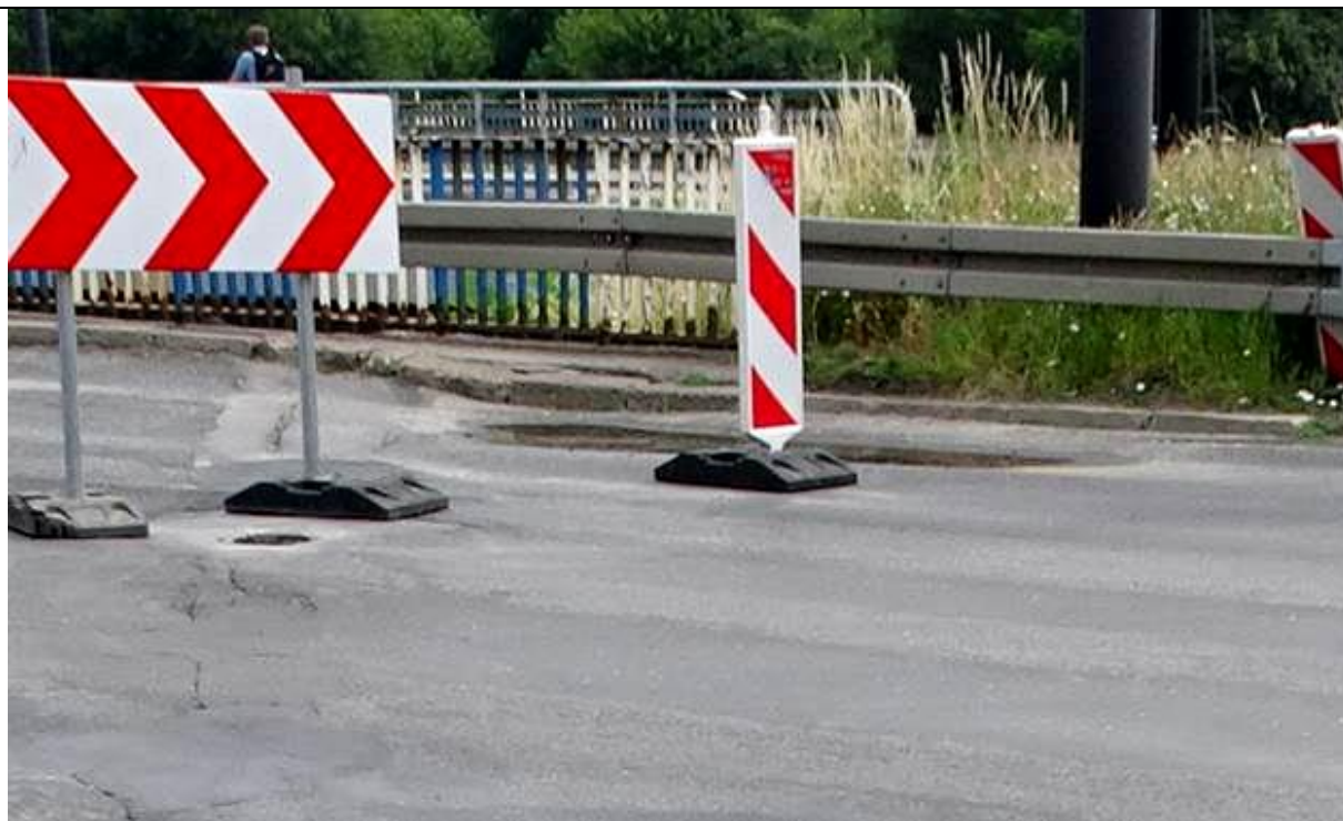
Fot. 10. Dojazd od str. ul. Fabrycznej. Zaniżenie nawierzchni jezdni o ok. 10 cm i deformacja krawężnika lewego spowodowana osiadaniem gruntu. Spękania i ubytki nawierzchni w obrębie dylatacji.
