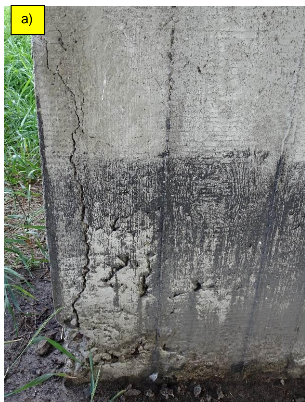
Fot. 44. Podpora L-2. Zarysowania pionowe w słupach spowodowane korozją zbrojenia: a) słup skrajny od GW; b) słup skrajny od DW.
