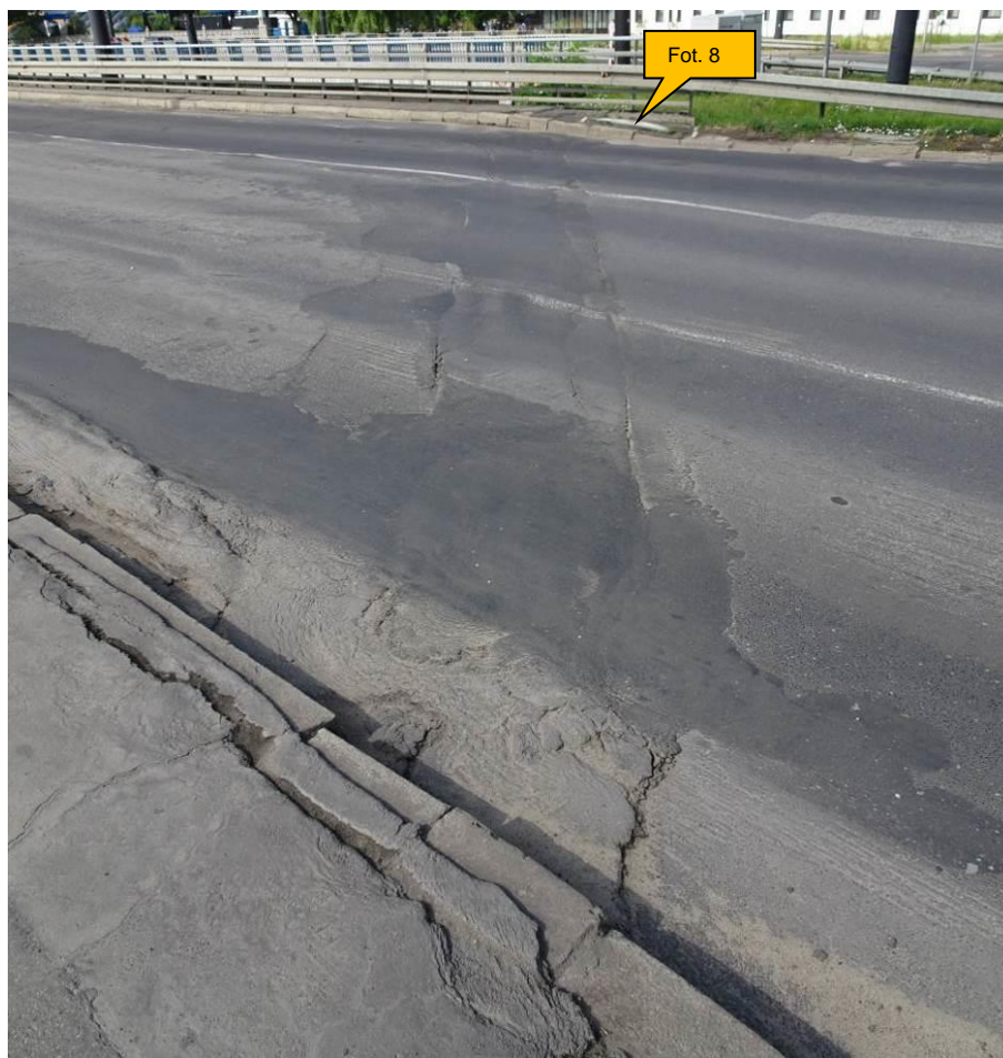
Fot. 7. Stan nawierzchni jezdni w obrębie dylatacji nad podporą L-1. Na moście i na dojeździe koleiny i deformacje nawierzchni o głębokości do ok. 5 cm (przy krawężniku do 10 cm). Pęknięcia nawierzchni wzdłuż dylatacji. Zaniżenie nawierzchni dojazdu o około 5-10 cm spowodowane osiadaniami. Deformacje krawężników spowodowane osiadaniami dojazdu.
