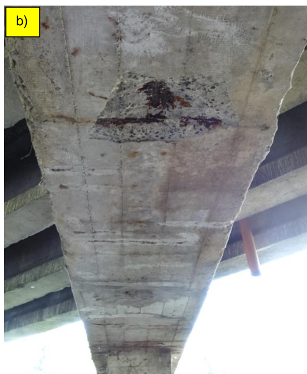
Fot. 41. Podpora P-2, dolna powierzchnia oczepu. Korozja strzemion spowodowana zbyt małą grubością otuliny oraz zawilgoceniem betonu w następstwie przecieków przez dylatacje.
