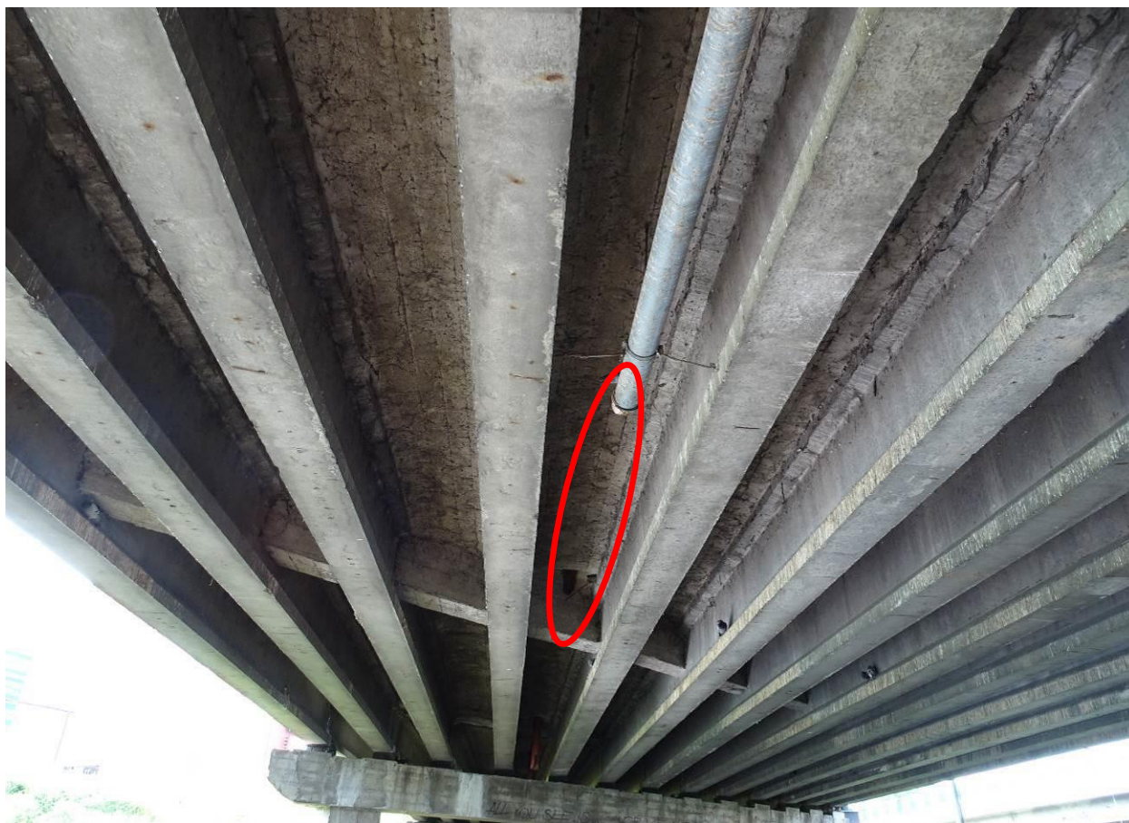
Fot. 24. Przesło nr 2, widok ogólny. Belki i płyta pomostu bez większych uszkodzeń. Ubytek rury spustowej (brakujący odcinek zaznaczono kolorem czerwonym).
