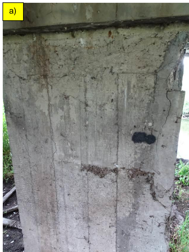
Fot. 51. Podpora P-3. Przykłady rys pionowych w słupach spowodowanych korozją zbrojenia.
