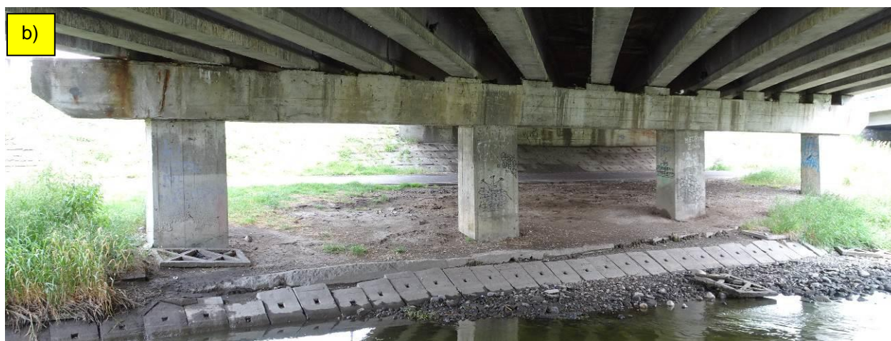
Fot. 38. Podpora P-2, widok od str. podpory P-1 (fot. a) i od str. podpory P-3 (fot. b). Na oczepie intensywne zacieki i przecieki spowodowane nieuszczelnnością dylatacji. W miejscach zacieków intensywna korozja betonu i zbrojenia oraz spękania i odpryski otuliny. Zarysowania i odpryski otuliny również w skrajnych słupach. Szczegóły uszkodzeń na kolejnych fotografiach na rys. 2.2.2.
