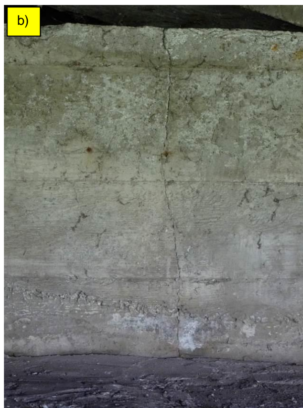
Fot. 35. Podpora P-4. Przykłady rys pionowych o rozwarości 1,6 mm w ścianie czołowej. Regularny rozstaw rys może wskazywać na ich skurczowe pochodzenie. Widoczna punktowa korozja zbrojenia.
