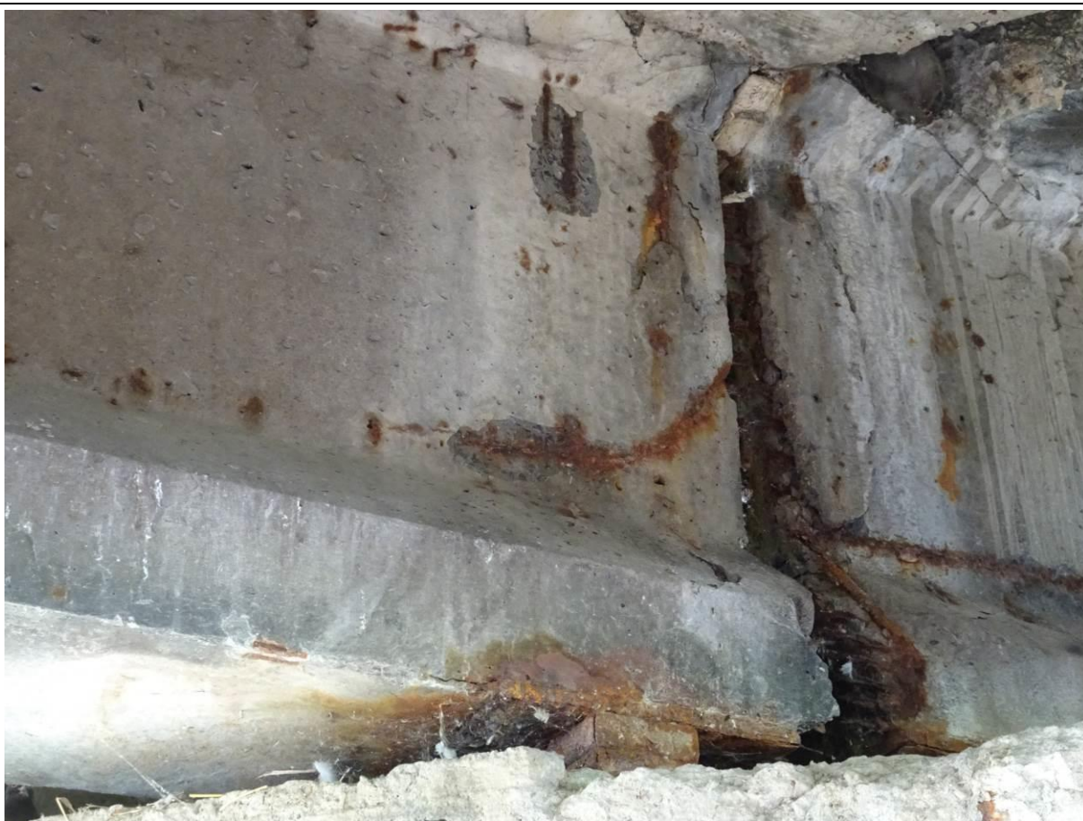
Fot. 23b. Konstrukcja przęsła nad podporą nr L-2. Korozja betonu i zbrojenia w belce nr 10 spowodowana przeciekami przez dylatację. Intensywna korozja łożyska.
