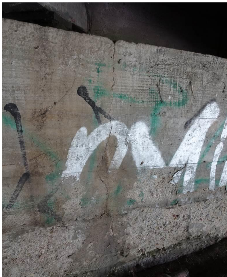
Fot. 33. Podpora L-1. Szczegół rysy pionowej o rozwarości 0,5 mm w połowie szerokości ściany czołowej.
