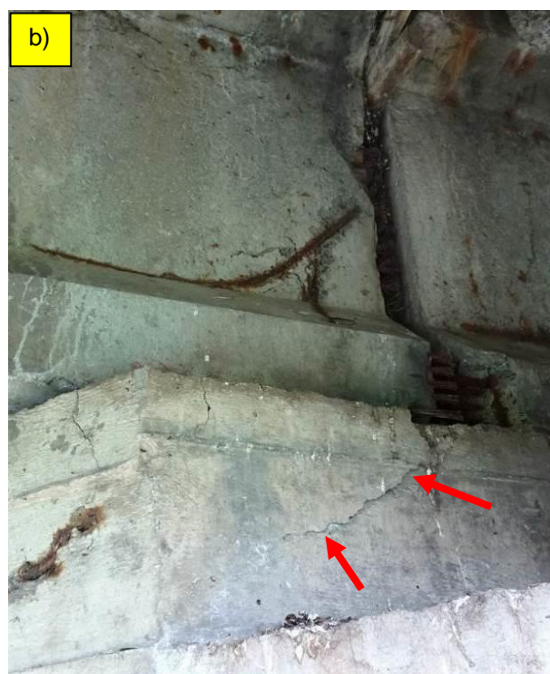
Fot. 41. Podpora P-2, dolna powierzchnia oczepu. Korozja strzemion spowodowana zbyt małą grubością otuliny oraz zawilgoceniem betonu w następstwie przecieków przez dylatacje.
