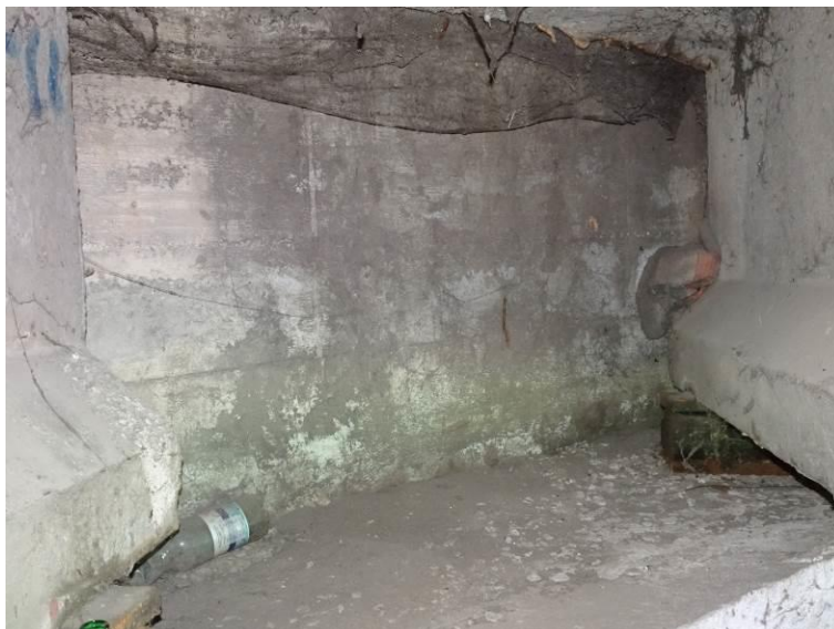
Fot. 31. Podpora P-1. Typowy stan ścianki zapleczonej i ławy podłożyskowej: zanieczyszczenia spowodowane przeciekami przez dylatację. Widoczna korozja łożysk.
