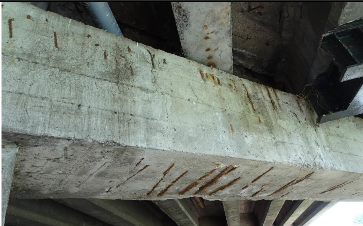
Fot. 41. Podpora L-2, widok od str. podpory P-3. Korozja betonu i zbrojenia (strzemion) w oczępie spowodowana przeciekami przez dylatację. Uszkodzenie występuje na odcinku o dług. ok. 4 mb pomiędzy słupami od str. DW.
