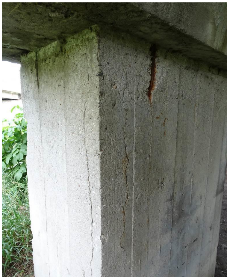
Fot. 50. Podpora L-3. Zarysowania wzdłuż krawędzi słupa skrajnego od GW spowodowane korozją zbrojenia.
