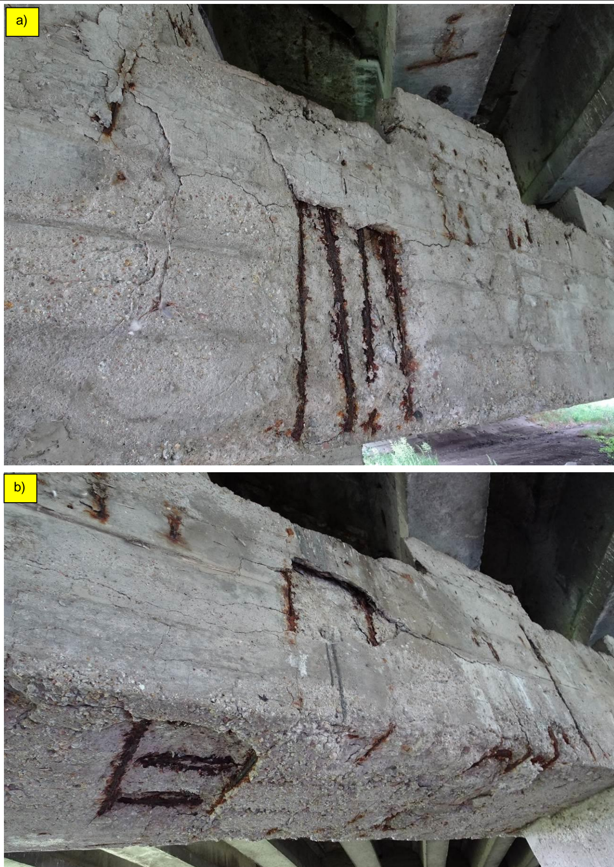
Fot. 45. Podpora P-3. Oczep pomiędzy słupami od DW, widok od str. podpory nr 2. Rozległe spękania, odspojenia i ubytki otuliny spowodowane intensywną korozją strzemion i zbrojenia głównego. Ubytki zbrojenia sięgają 100% przekroju prętów.
