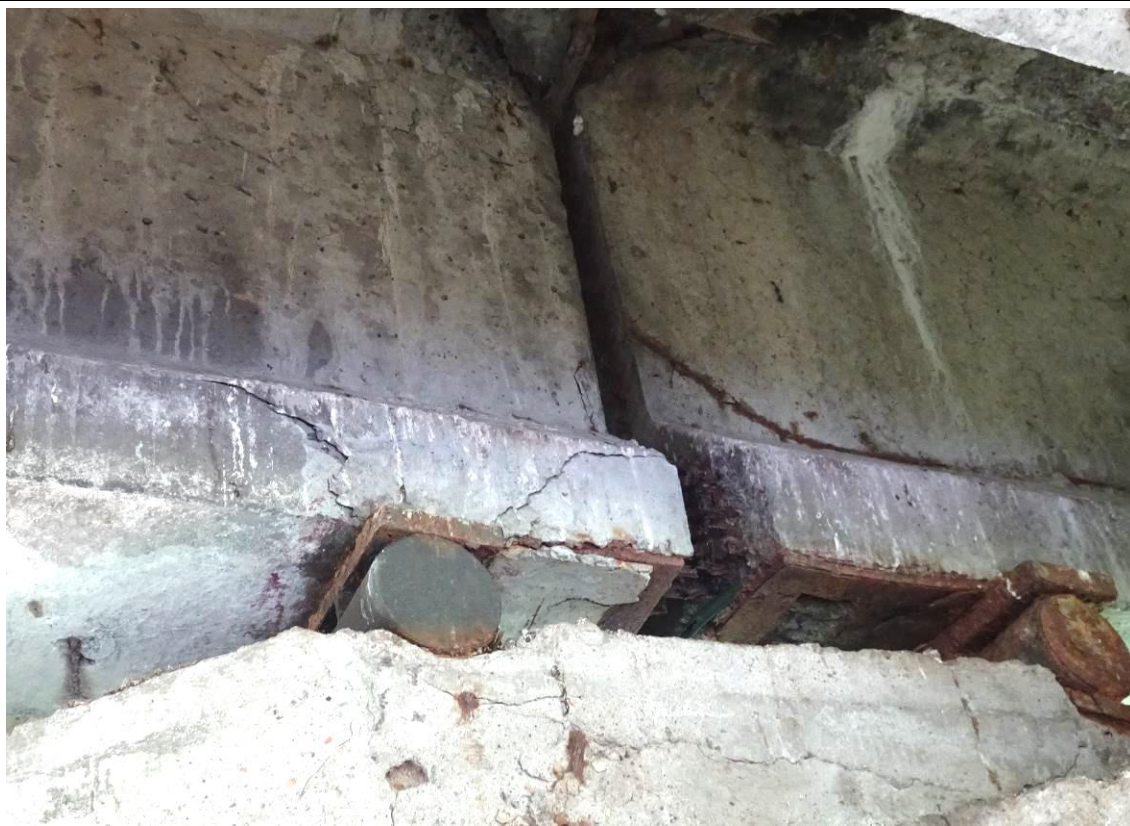
Fot. 25d. Uszkodzenia belki nr 12 nad podporą P-3. Spękania otuliny w półce dolnej nad łożyskiem spowodowane korozją zbrojenia. Korozja łożysk wałkowych i blach nadłożyskowych.
