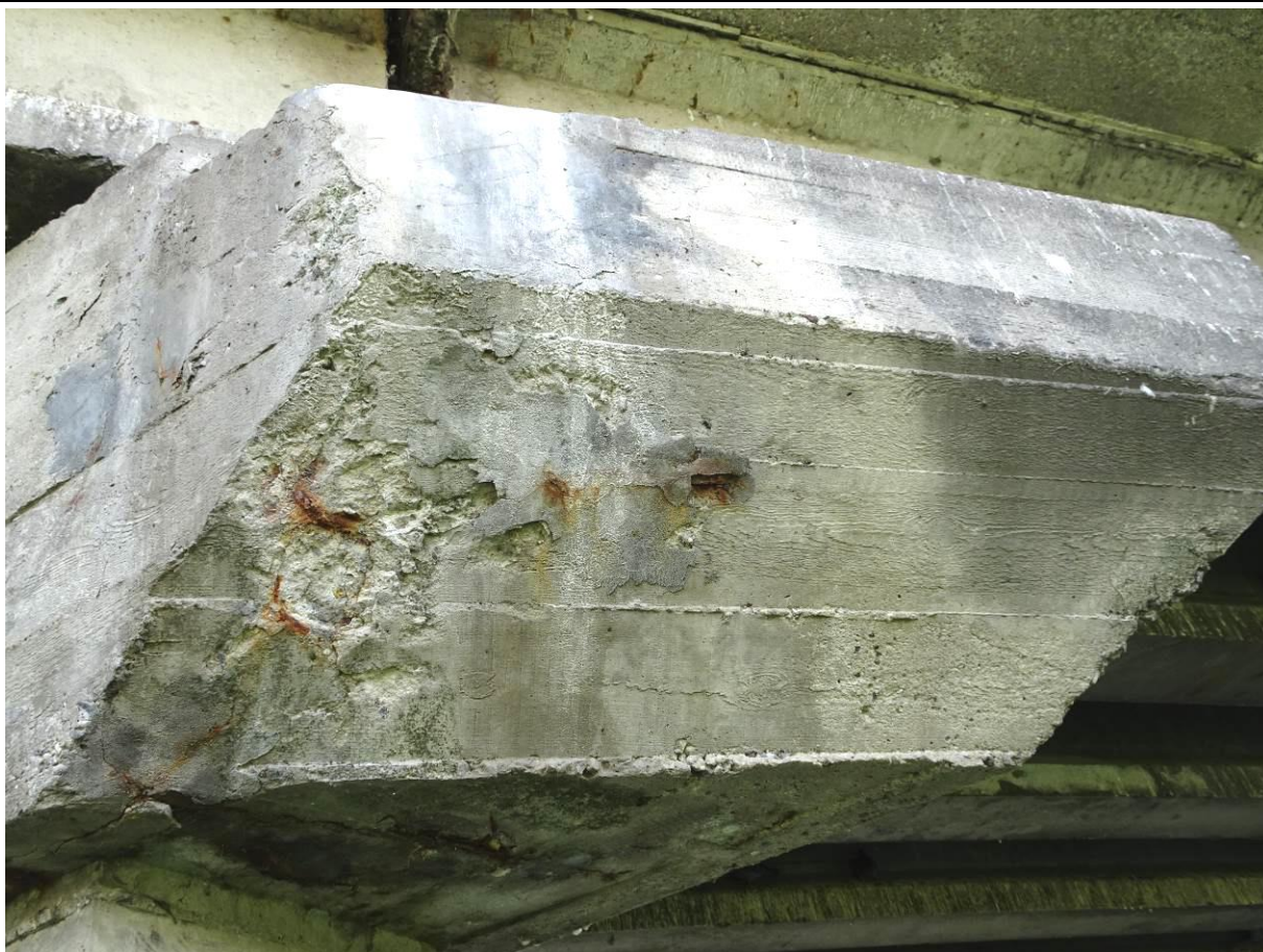
Fot. 42. Podpora L-2. Niewielkie odpryski betonu i korozja zbrojenia na wsporniku oczępu od str. GW.
