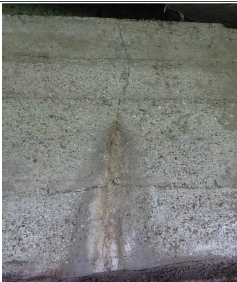
Fot. 36b. Podpora L-4. Szczegół rysy pionowej o rozwartości 0,5 mm w połowie szerokości ściany czołowej. W dolnej części rysy przeciek z wykwitem.
