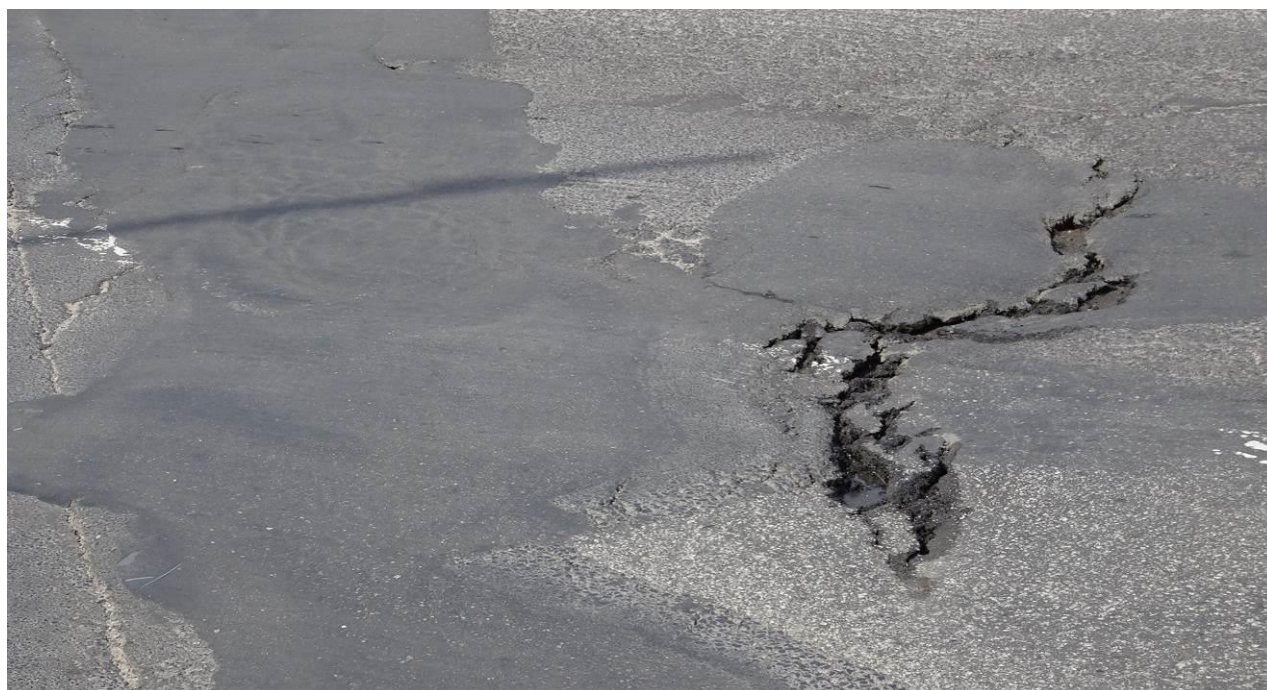
Fot. 10. Szczegół ubytku nawierzchni nad podporą L-4.
