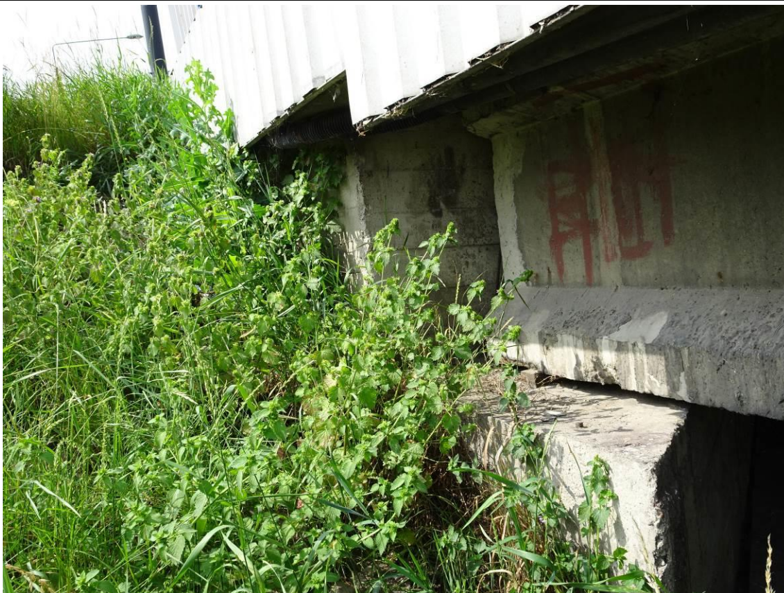
Fot. 37. Podpora L-4, widok od DW. Konstrukcja bez uszkodzeń. Bujna wegetacja na stożku.
