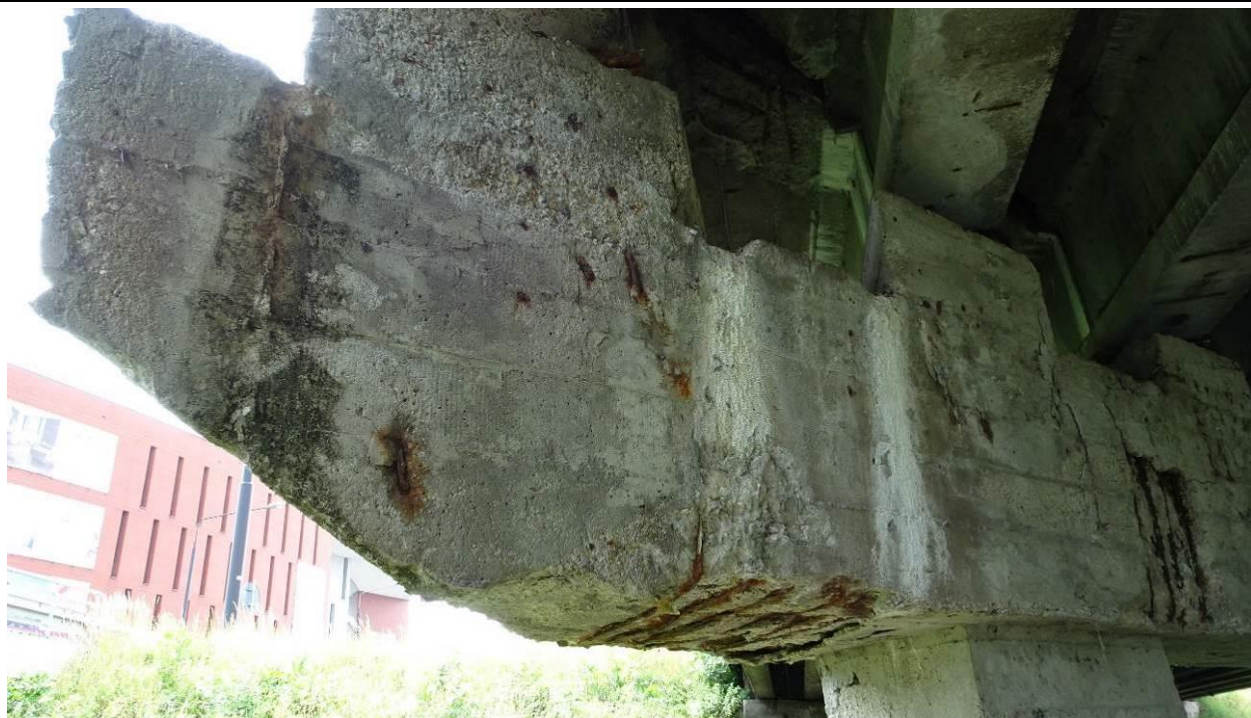
Fot. 44. Podpora P-3, wspornik oczepu od DW. Rozległe ubytki betonu odsłaniające skorodowane strzemiona. Ubytki zbrojenia sięgają 100% przekroju prętów. Uszkodzenia spowodowane zciekami z dylatacji.
