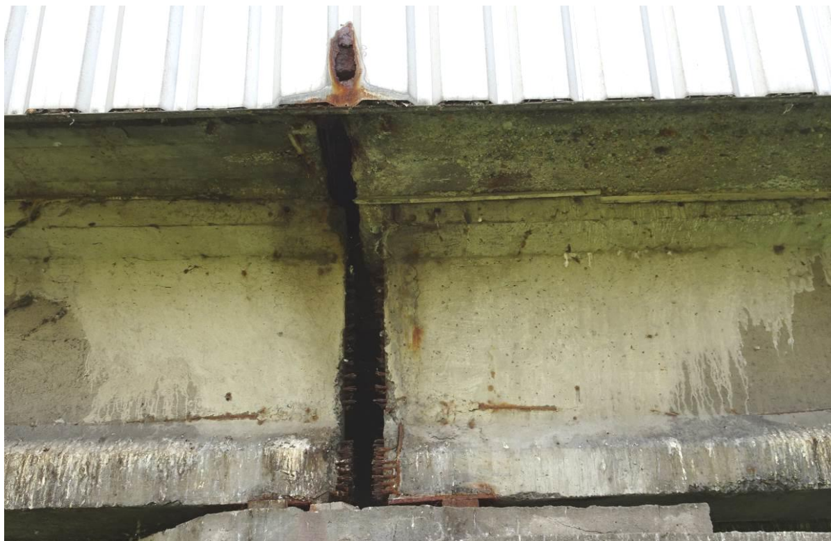
Fot. 23d. Przecieki przez dylatację nad podporą L-2 od str. GW. Korozja betonu i zbrojenia w strefach podporowych belek. Korozja łożysk stykowych. Perforacja korozyjna blachy gzymsowej.
