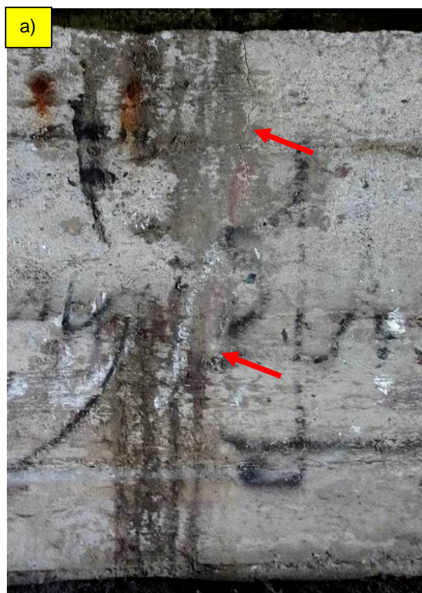
Fot. 30. Podpora P-1. Przykłady rys pionowych o rozwarości 1,0 mm w ścianie czołowej. Regularny rozstaw rys może wskazywać na ich skurczowe pochodzenie. Widoczna punktowa korozja zbrojenia.
