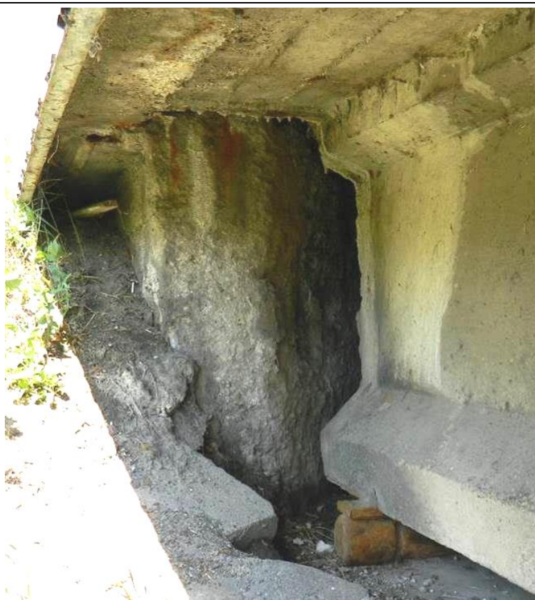
Fot. 30. Podpora L-1. Powierzchniowe ubytki betonu w narożu ścianki zapleczej od str. GW. Zacieki na ścianie i belce spowodowane nieuszczelniościami dylatacji. Korozja łożyska.
