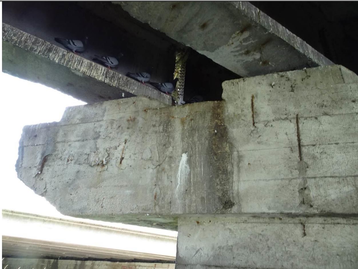
Fot. 43. Podpora L-2, widok od str. podpory P-3. Niewielkie ubytki betonu, wykwyty świadczące o przeciekach oraz korozja odsłoniętych strzemion na wsporniku oczepu od GW.
