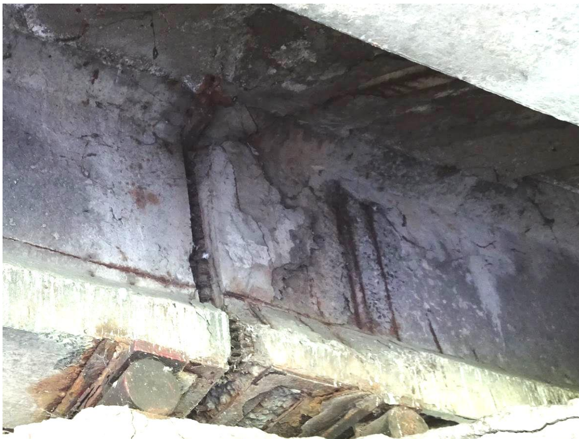
Fot. 25a. Uszkodzenia belki nr 6 nad podporą P-3. Rozległe ubytki otuliny odsłaniające skorodowane strzemiona w środku belki. Skorodowane blachy nadłożyskowe w belkach.
