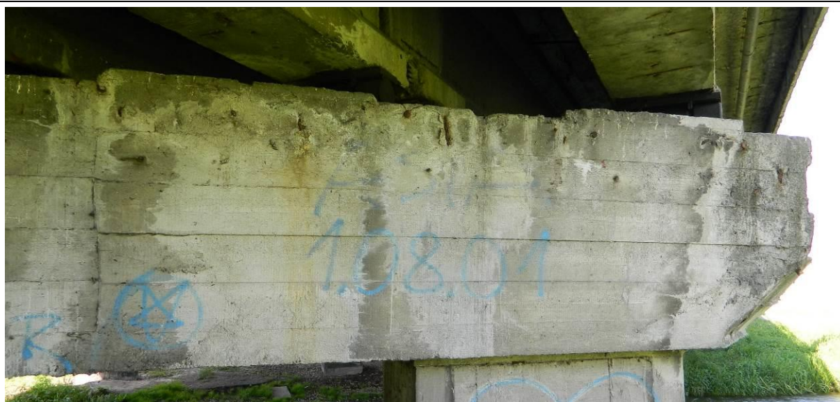
Fot. 48. Podpora L-3, widok ogólny od str. podpory L-4. Zacieki i wykwyty w oczepie nad skrajnym słupem od DW. Lokalna korozja strzemion.
