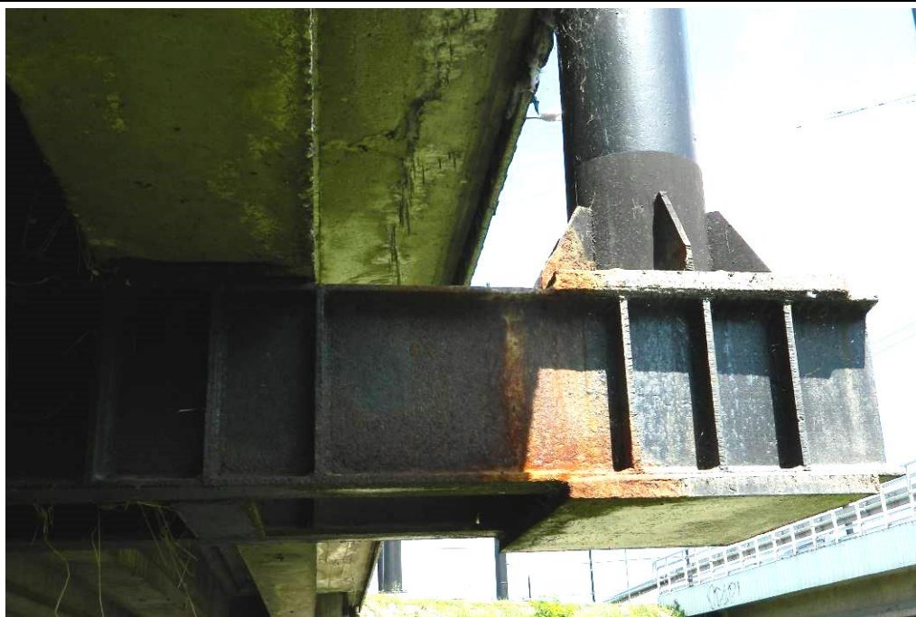
Fot. 52. Typowe uszkodzenie konstrukcji mocujących słupy trakcji trolejbusowej. Korozja elementu spowodowana przeciekami przez pomost.
