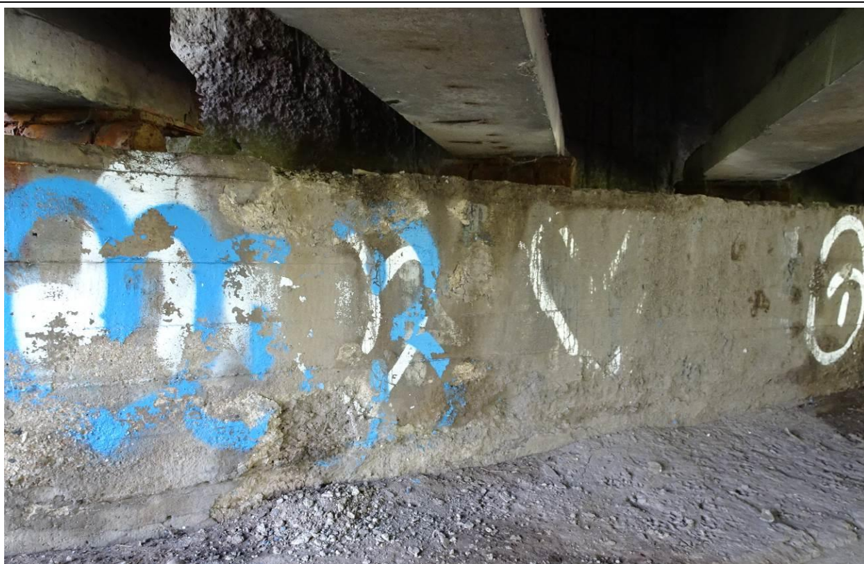
Fot. 32b. Podpora L-1. Powierzchniowe ubytki spowodowane korozją betonu w ścianie czołowej, występujące łącznie na ok. 25% powierzchni ściany, głównie od str. GW. Widoczne zanieczyszczenie ściany w wyniku zacieków z dylatacji.
