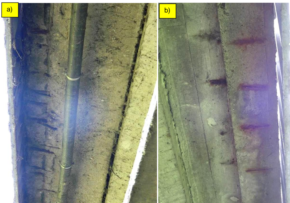
Fot. 25. Typowe uszkodzenia belki gzymsowej od DW (fot. a) i od GW (fot. b) występujące na długości przęsła nr 2 i 3. Przecieki, powierzchniowe ubytki betonu i korozja odsłoniętego zbrojenia.
