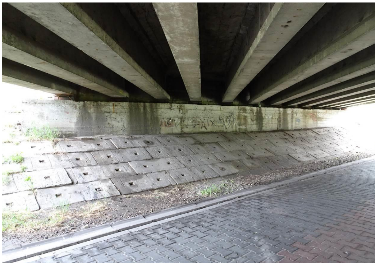
Fot. 6. Widok spodu konstrukcji przęsła oraz przyczółka lewobrzeżnego (podpora P-1)
