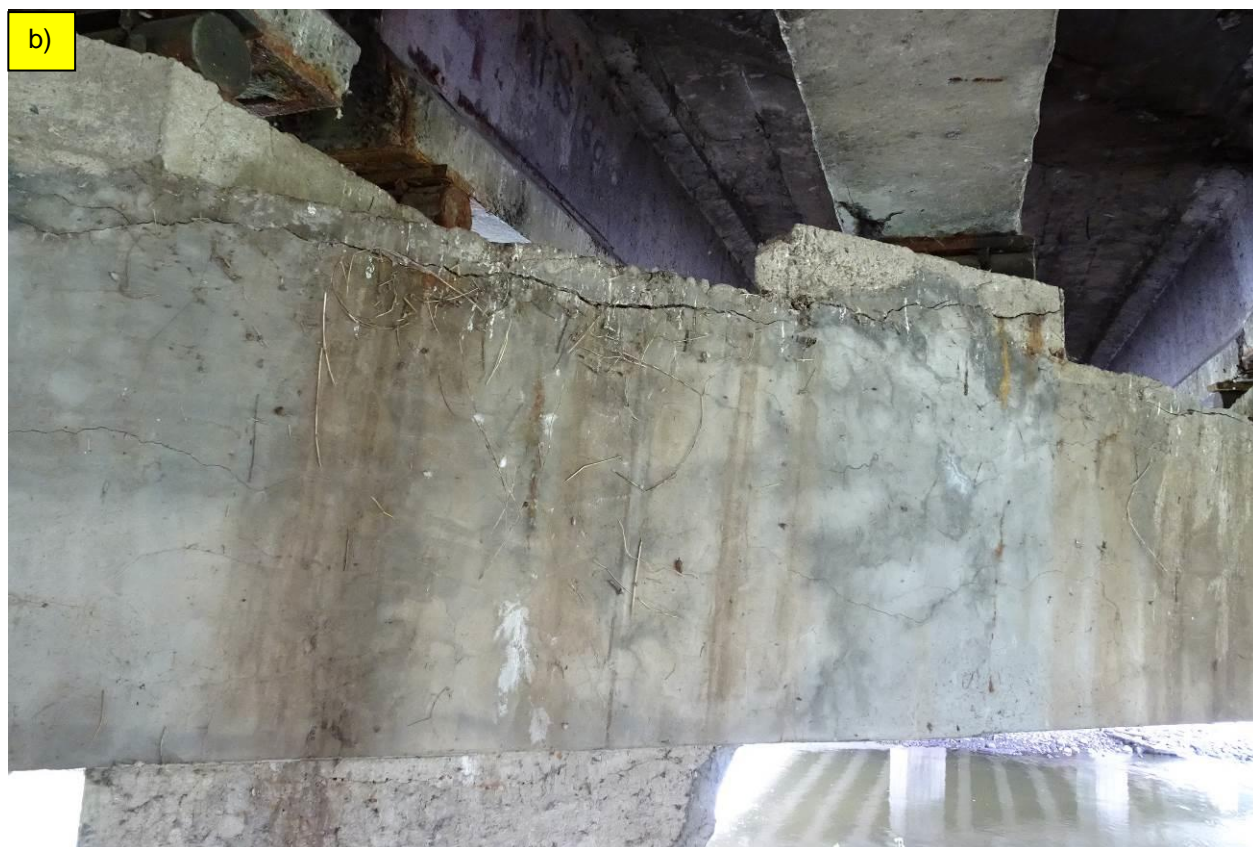
Fot. 47. Podpora P-3. Środkowa część oczepu, widok od str. podpory nr 4. Rozległe spękania otuliny spowodowane korozją zbrojenia. W miejscach spękań wycieki i wykwyty. Na fot. b) widoczne spękania betonu w ciosie podłożyskowym.
