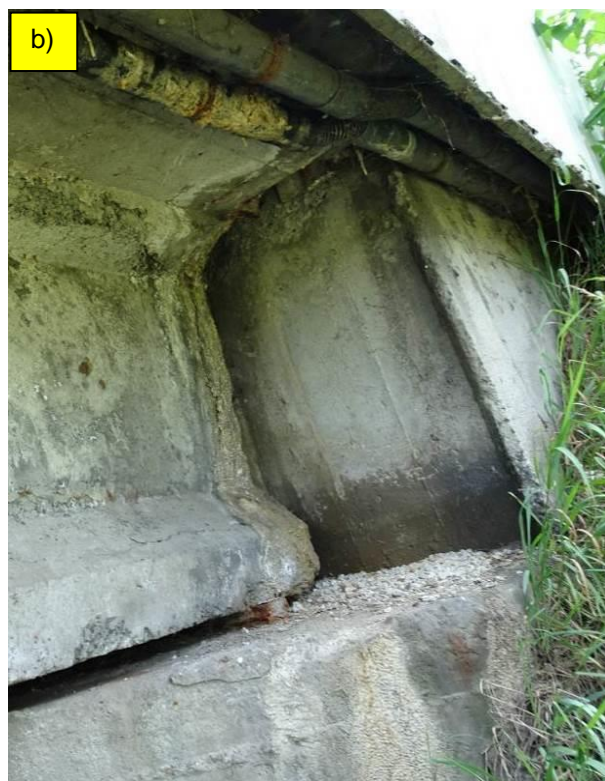
Fot. 37. Podpora P-4, widok od str. DW (fot. a) i od str. GW (fot. b). Zawilgocenie i korozja betonu w ścianie zapleczonej i w belkach spowodowane przeciekami przez dylatację. Korozja łożysk stycznych. Wegetacja roślinna na stożkach powodująca zacinienie skrzydeł.
