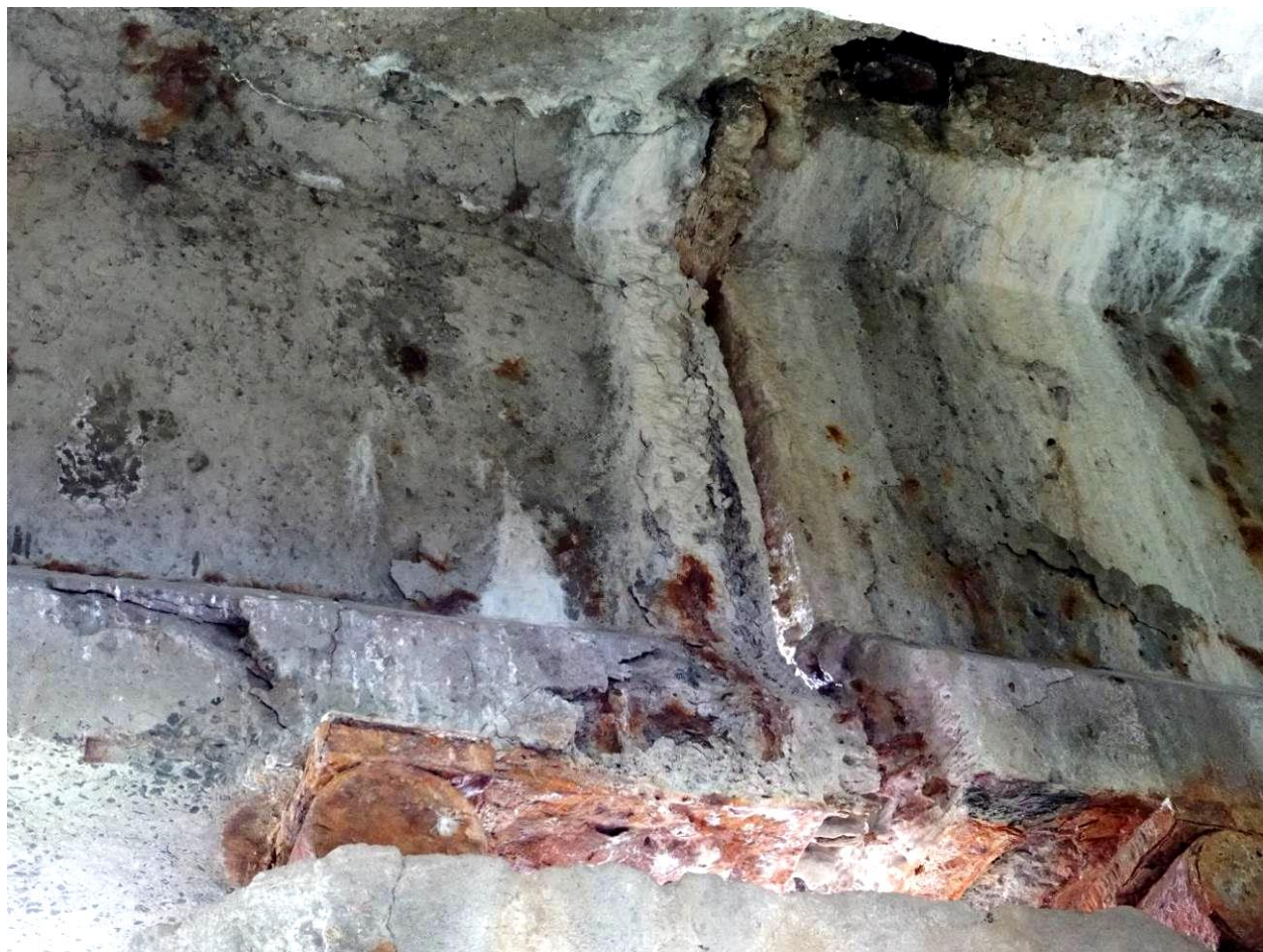
Fot. 26a. Uszkodzenia belek skrajnych od DW nad podporą P-3. Intensywna korozja betonu i zbrojenia oraz spękania i odpryski otuliny. Korozja łożysk wałkowych i blach nadłożyskowych. Uszkodzenia spowodowane przeciekami przez dylatację.
