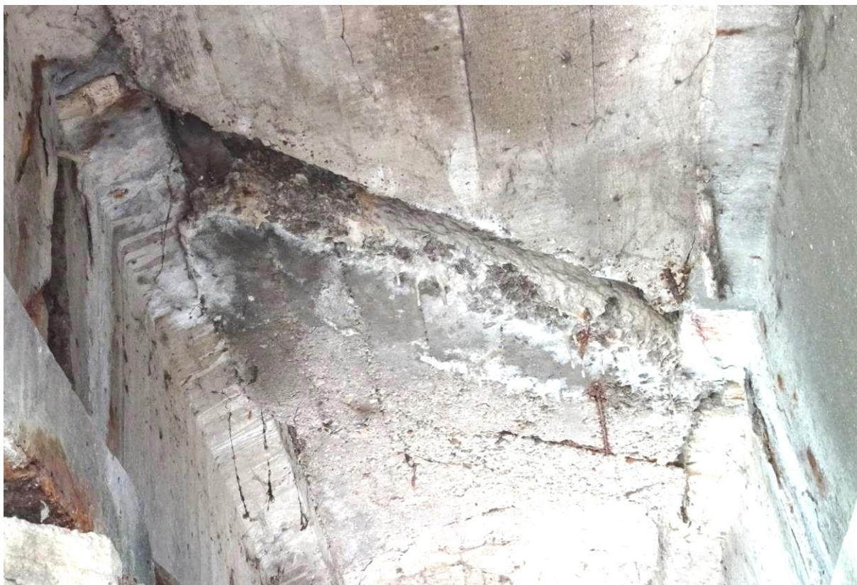
Fot. 23a. Konstrukcja przęsła nad podporą nr L-2. Zacieki na płycie pomostu i belkach spowodowane nieszczelnością dylatacji.
