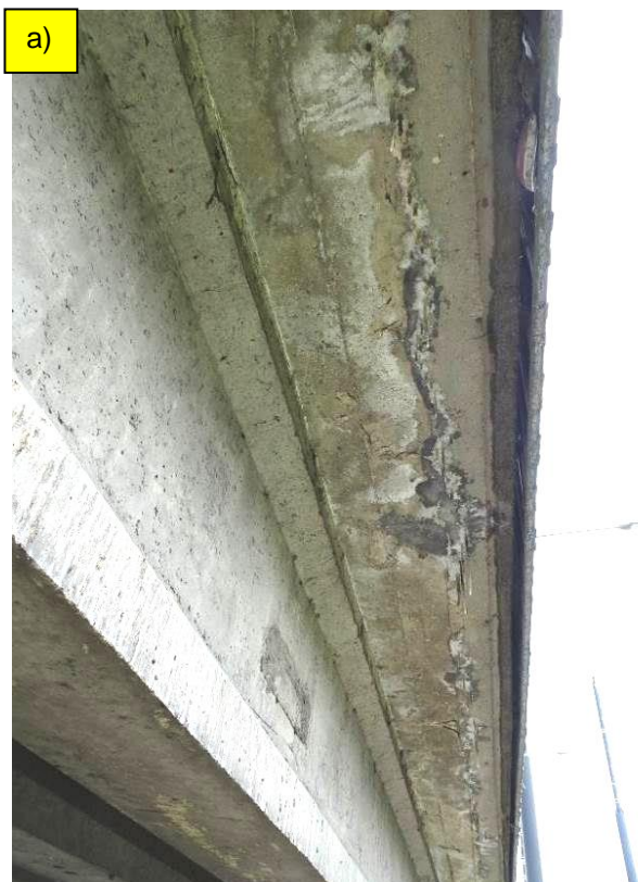
Fot. 15. Przęsło nr 1, widok w kierunku podpory P-1. Na ok. 10% powierzchni płyty widoczne przebarwienia i wykwyty świadczące o przeciekach przez pomost (fot. 16, 17). W belkach uszkodzenia występują w strefach podporowych (fot. 18÷20), stan stref przęsłowych nie budzi istotnych zastrzeżeń.
