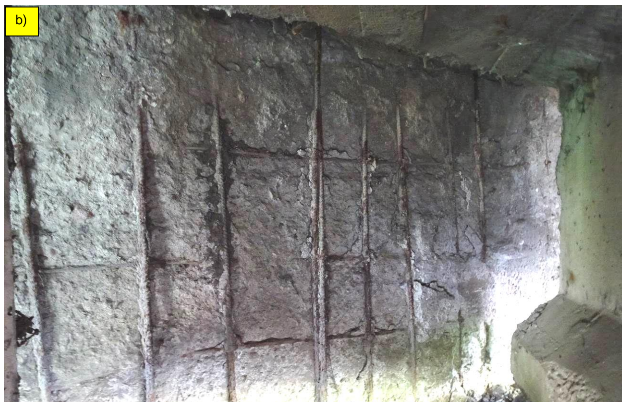
Fot. 31. Podpora L-1. Ubytki betonu odsłaniające zbrojenie ścianki zapleczej na długości ok. 4 m od krawędzi przyczółka od str. GW. Intensywna korozja łożysk. Uszkodzenia spowodowane przeciekami przez dylatację.
