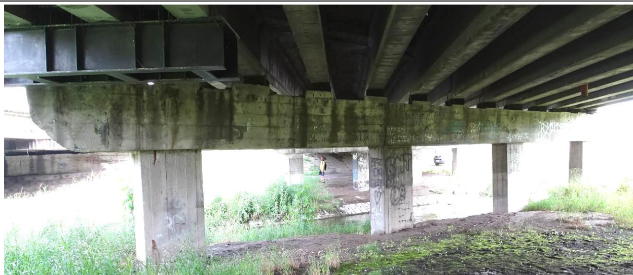
Fot. 46. Podpora L-3, widok ogólny od str. podpory L-4. Zacieki na powierzchni i lokalna korozja odsłoniętych strzemion.
