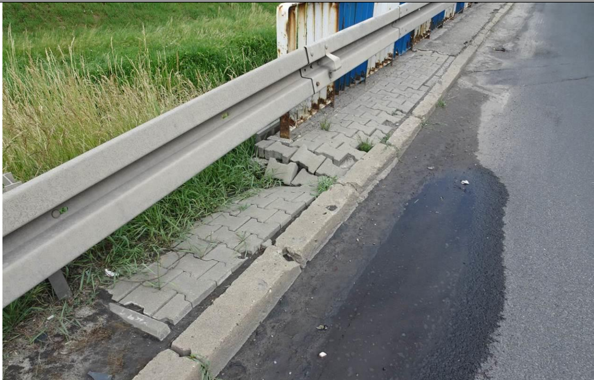
Fot. 11. Dojazd od str. ul. Fabrycznej. Zapadnięte nawierzchnia opaski i zaniżona nawierzchnia dojazdu. Uszkodzenia spowodowane osiadaniem gruntu i erozyjnym działaniem wody opadowej. Widoczna korozja balustrady.
