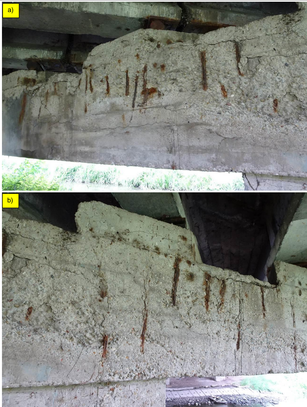
Fot. 48. Podpora P-3. Środkowa część oczepu, widok od str. podpory nr 4. Rozległe spękania i ubytki otuliny spowodowane intensywną korozją zbrojenia. Na fot b) widoczne spękania betonu w ciosie podłożyskowym.
