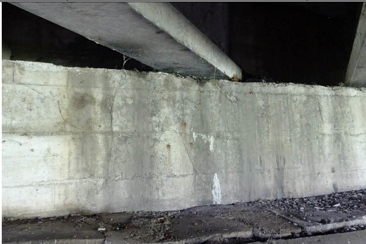
Fot. 36b. Podpora P-4. Zanieczyszczenia w środkowej części przyczółka spowodowane przeciekami przez dylatację. Lokalne przecieki i wykwyty świadczące o korozji betonu. Punktowa korozja zbrojenia.
