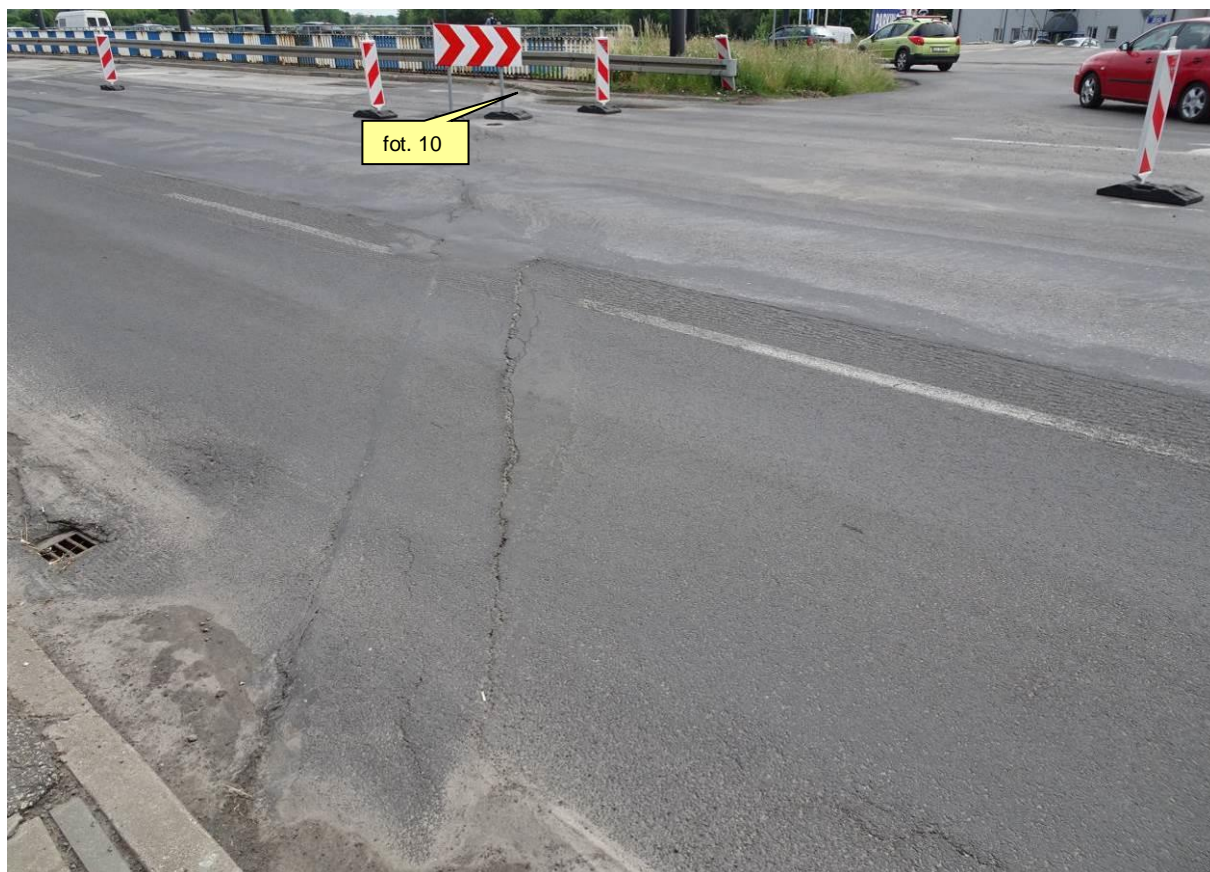
Fot. 9. Dojazd od str. ul. Fabrycznej i dylatacja nad podporą P-4. Koleiny w nawierzchni dojazdu i na moście o głębokości ok. 5 cm. Lokalne garby i zaniżenia nawierzchni. Spękania i wykruszenia nawierzchni wzdłuż dylatacji.
