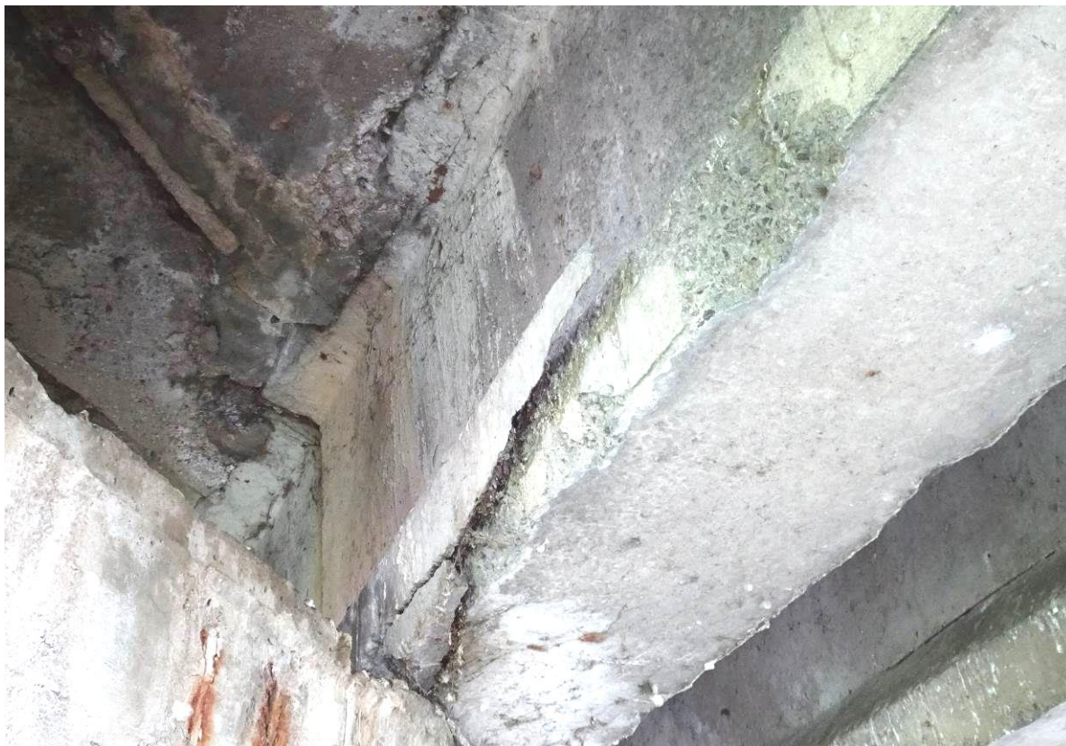
Fot. 23. Przęsło 2-3. Belka nr 2 nad podporą P-2. Odspojenie otuliny w półce dolnej spowodowane korozją zbrojenia w następstwie przecieków przez dylatację.
