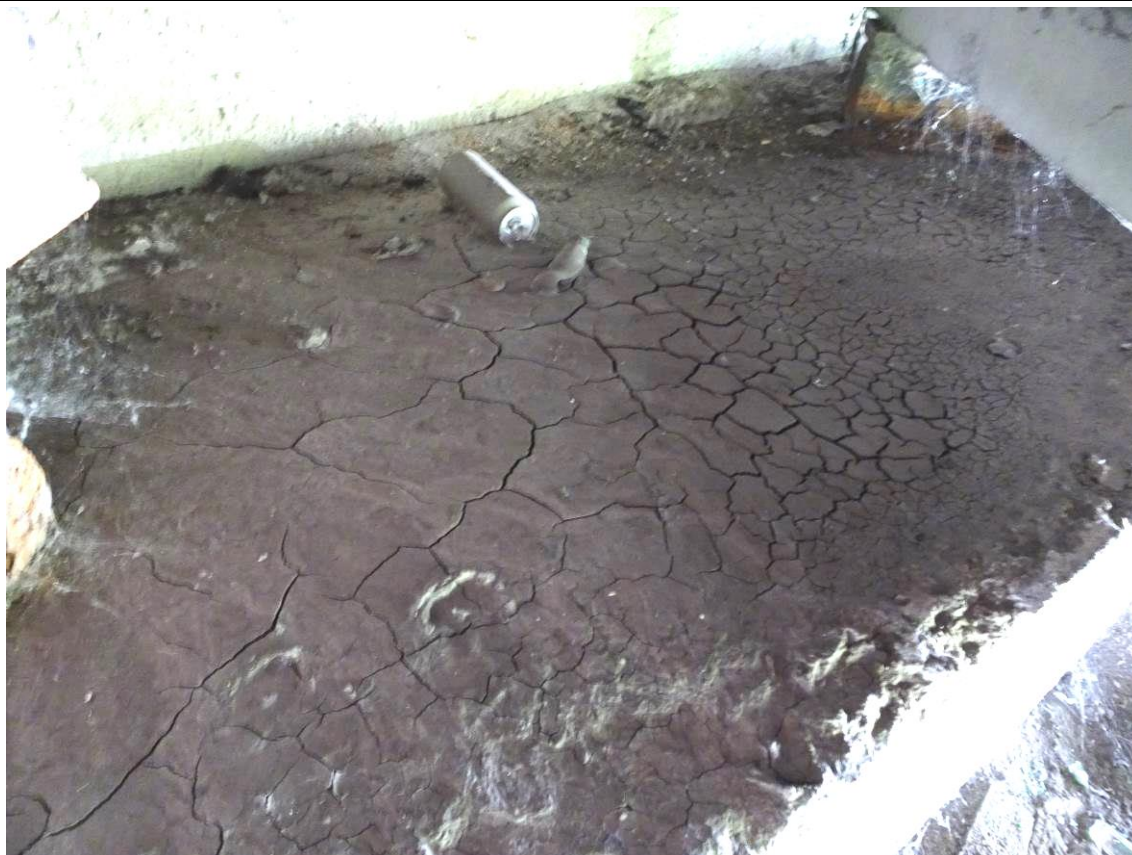
Fot. 32a. Podpora L-1. Gruba warstwa zaschniętego błota na ławie podłożyskowej, naniesiona przez wodę przeciekającą przez dylatację.
