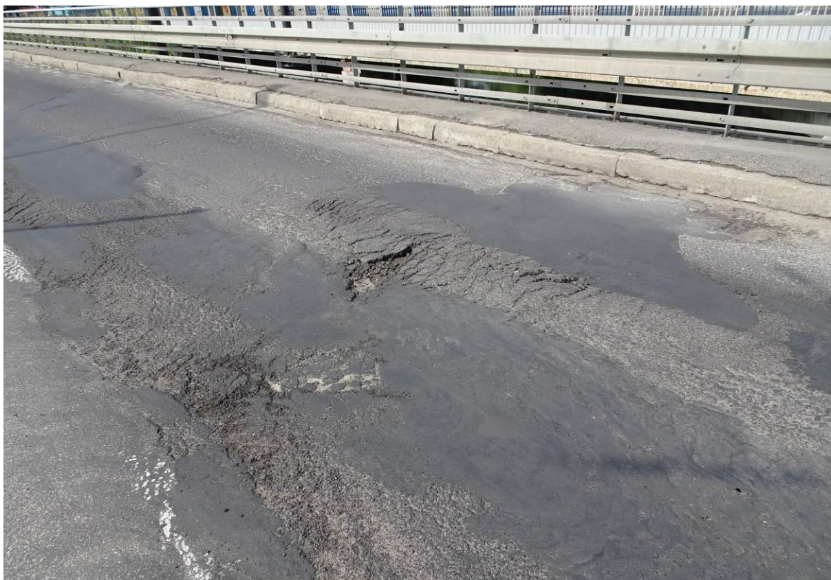
Fot. 13. Ubytki nawierzchni na skrajnym lewym pasie ruchu w prześle środkowym. Powierzchnia uszkodzeń wynosi ok. 15 m 2 . W miejscu ubytków widać zniszczoną dylatację pomostu.
