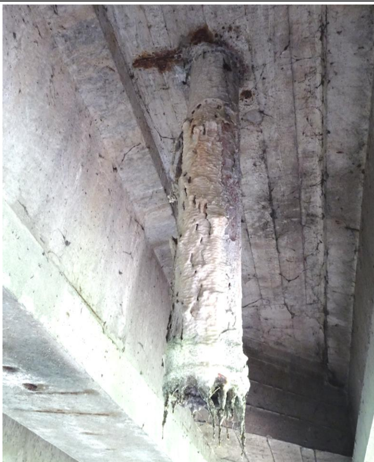
Fot. 28b. Przęsło nr 3. Zanieczyszczenie rury spustowej produktami korozji ługującej betonu w wyniku przecieków wokół wpustu.
