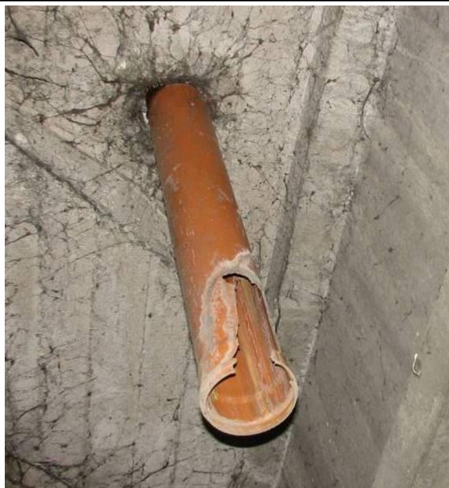
Fot. 26. Uszkodzona rura spustowa w prześle nr 2. Rury spustowe zbyt krótkie – sięgają dolnej powierzchni belek.
