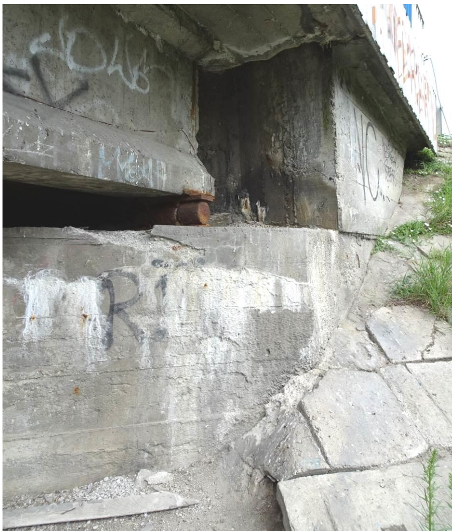
Fot. 32. Podpora P-1. Zarysowania ukośne z przeciekami w narożu ściany czołowej od str. DW. Intensywna korozja betonu i punktowa korozja zbrojenia. Zawilgocenie i wykwyty na ścianie zapleczonej. Korozja łożyska wałkowego. Uszkodzenia spowodowane przeciekami przez dylatację. Niewielkie deformacje umocnienia stożka.
