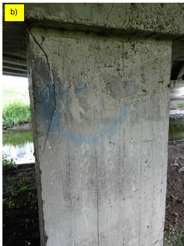
Fot. 51. Podpora P-3. Przykłady rys pionowych w słupach spowodowanych korozją zbrojenia.
