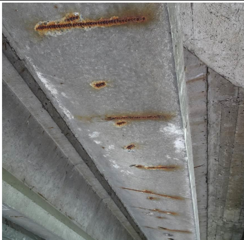
Fot. 18. Przęsło nr 1. Przykład korozji strzemion w półce dolnej belki spowodowanej wadą wytwórczą belki (brakiem otuliny betonowej).
