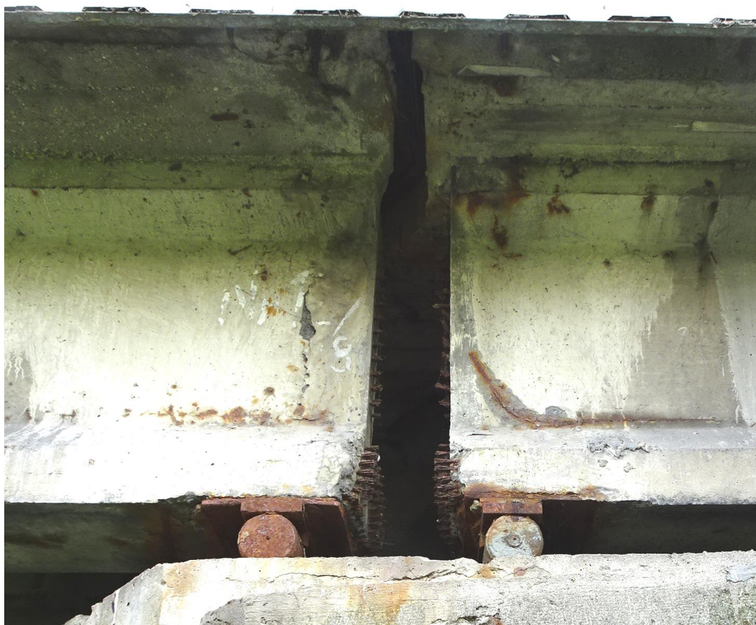
Fot. 27. Belki skrajne od GW nad podporą L-3. Wykwity na powierzchni płyty pomostu i belek oraz korozja zbrojenia spowodowane przeciekami przez dylatację. Korozja łożysk wałkowych.
