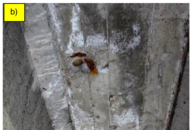
Fot. 15. Przęsło nr 1, widok w kierunku podpory P-1. Na ok. 10% powierzchni płyty widoczne przebarwienia i wykwyty świadczące o przeciekach przez pomost (fot. 16, 17). W belkach uszkodzenia występują w strefach podporowych (fot. 18÷20), stan stref przęsłowych nie budzi istotnych zastrzeżeń.
