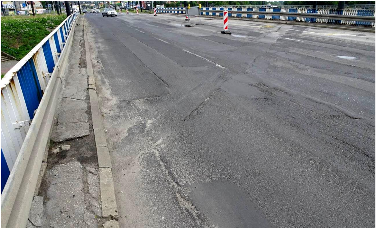
Fot. 13. Fotografia wykonana w rejonie dylatacji nad podporą P-3. Typowe uszkodzenia elementów wyposażenia mostu: koleiny i lokalne deformacje o głębokości do ok. 5 cm oraz spękania siatkowe nawierzchni jezdni. Rozległe ubytki nawierzchni opaski prawostronnej. Spękania wzdłuż dylatacji. Niedrożne kratki ściekowe. Korozja balustrady.
