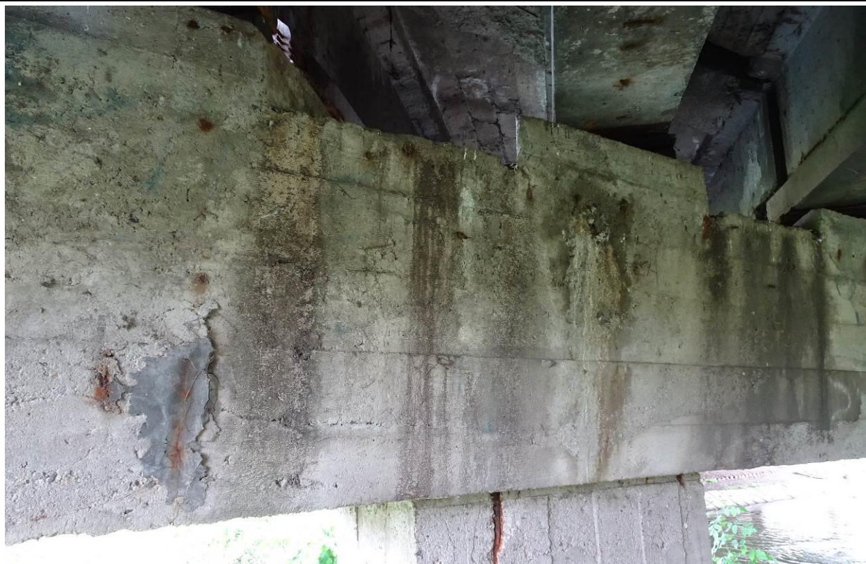
Fot. 47. Podpora L-3, widok ogólny od str. podpory L-4. Zacieki i wykwyty w oczepie nad skrajnym słupem od GW. Lokalna korozja strzemion.
