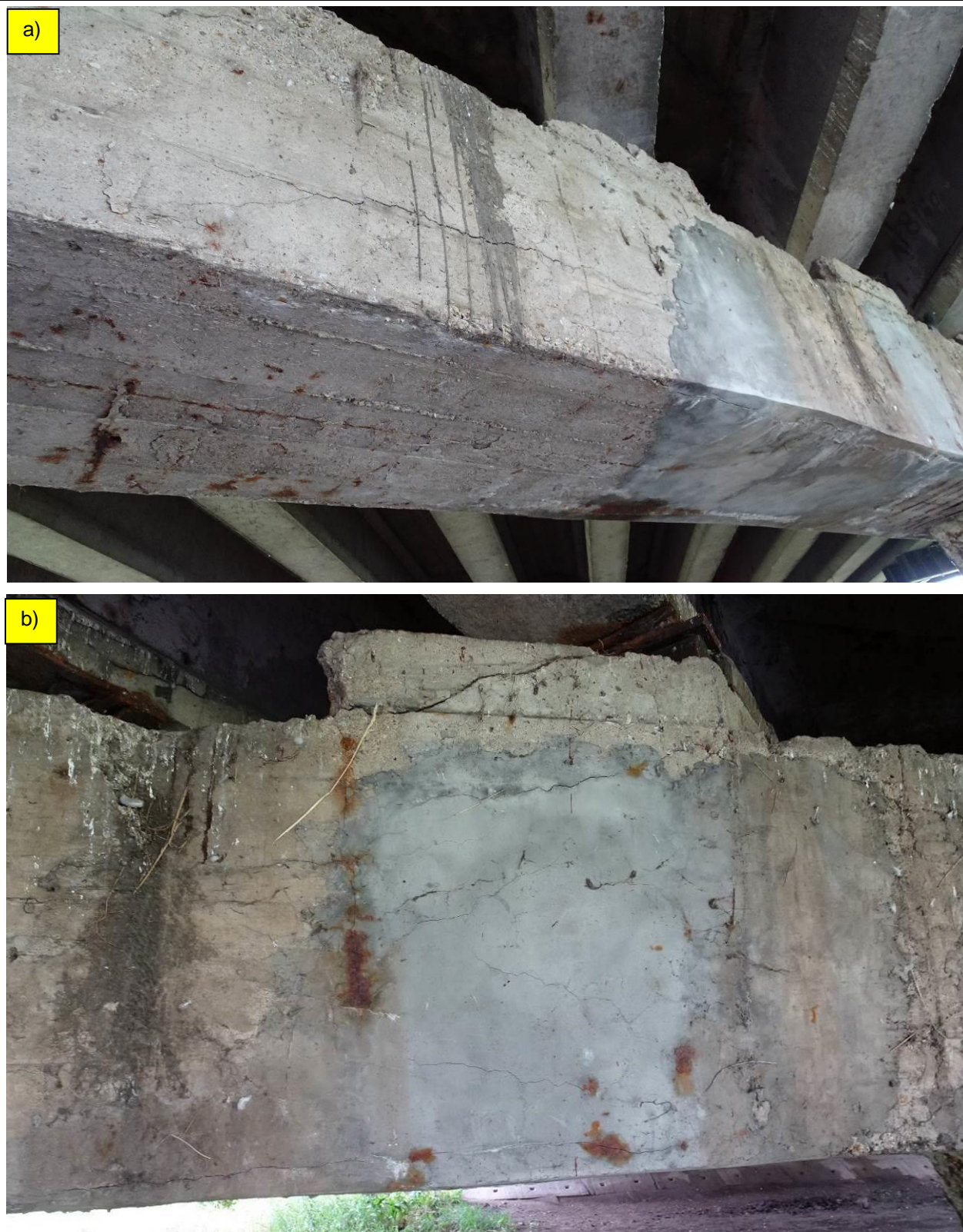
Fot. 46. Podpora P-3. Środkowa część oczepu, widok od str. podpory nr 2. Rozległe spękania otuliny spowodowane intensywną korozją zbrojenia. Na dolnej powierzchni wykwyty świadczące o przeciekach przez oczep. Na fot. b) widoczne pęknięcie ciosu podłożyskowego. Ślady nieskutecznych napraw betonu.
