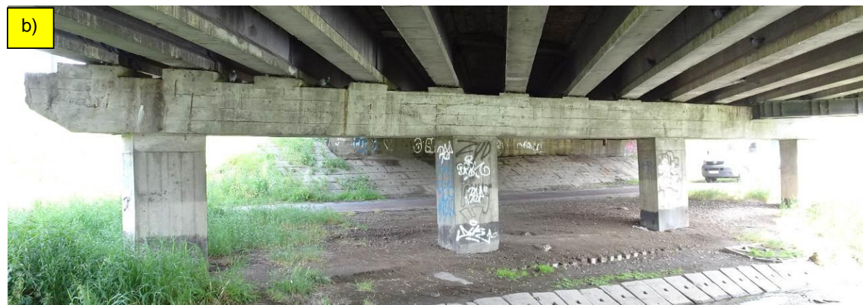
Fot. 39. Podpora L-2, widok od str. podpory L-1 (a) i podpory L-3 (b). Zacieki, korozja betonu i zbrojenia w oczipie spowodowana zaciekami wody z dylatacji. Szczegóły uszkodzeń na kolejnych fotografiach i na rys. 2.2.2.
