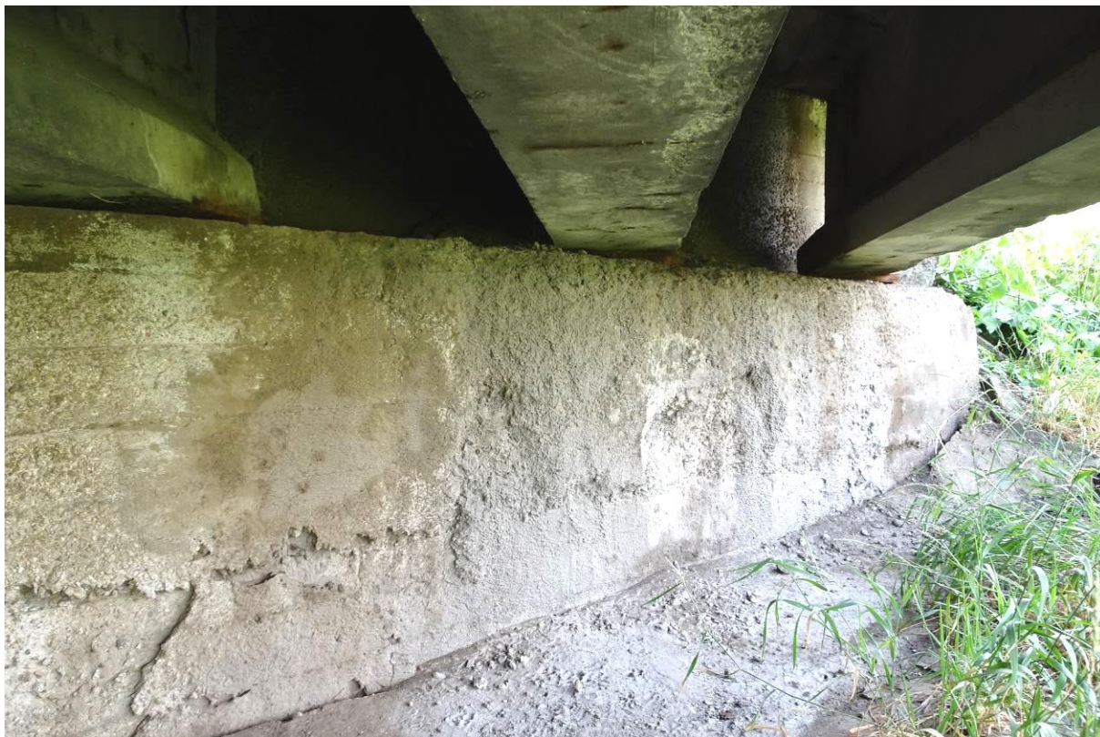
Fot. 35a. Podpora L-4. Korozja i ubytki powierzchniowe betonu w ścianie czołowej od str. GW na powierzchni ok. 8 m 2 , spowodowane zawilgoceniem betonu przez zacieki z dylatacji.
