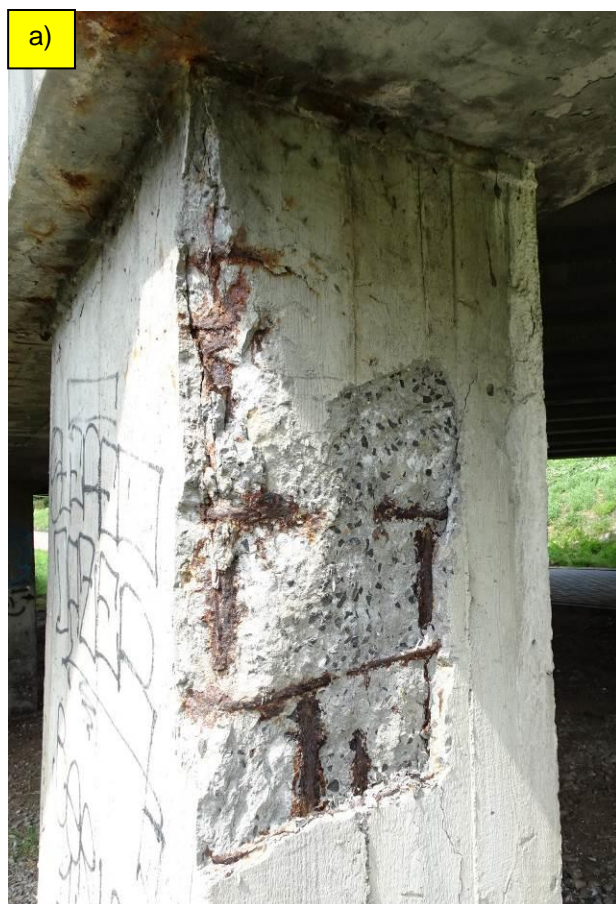
Fot. 42. Podpora P-2. a) słup skrajny od DW - spękania i odpryski otuliny spowodowane intensywną korozją zbrojenia głównego i strzemion; b) odpryski betonu w ciosie podłożyskowym pod belką przedskrajną od DW.
