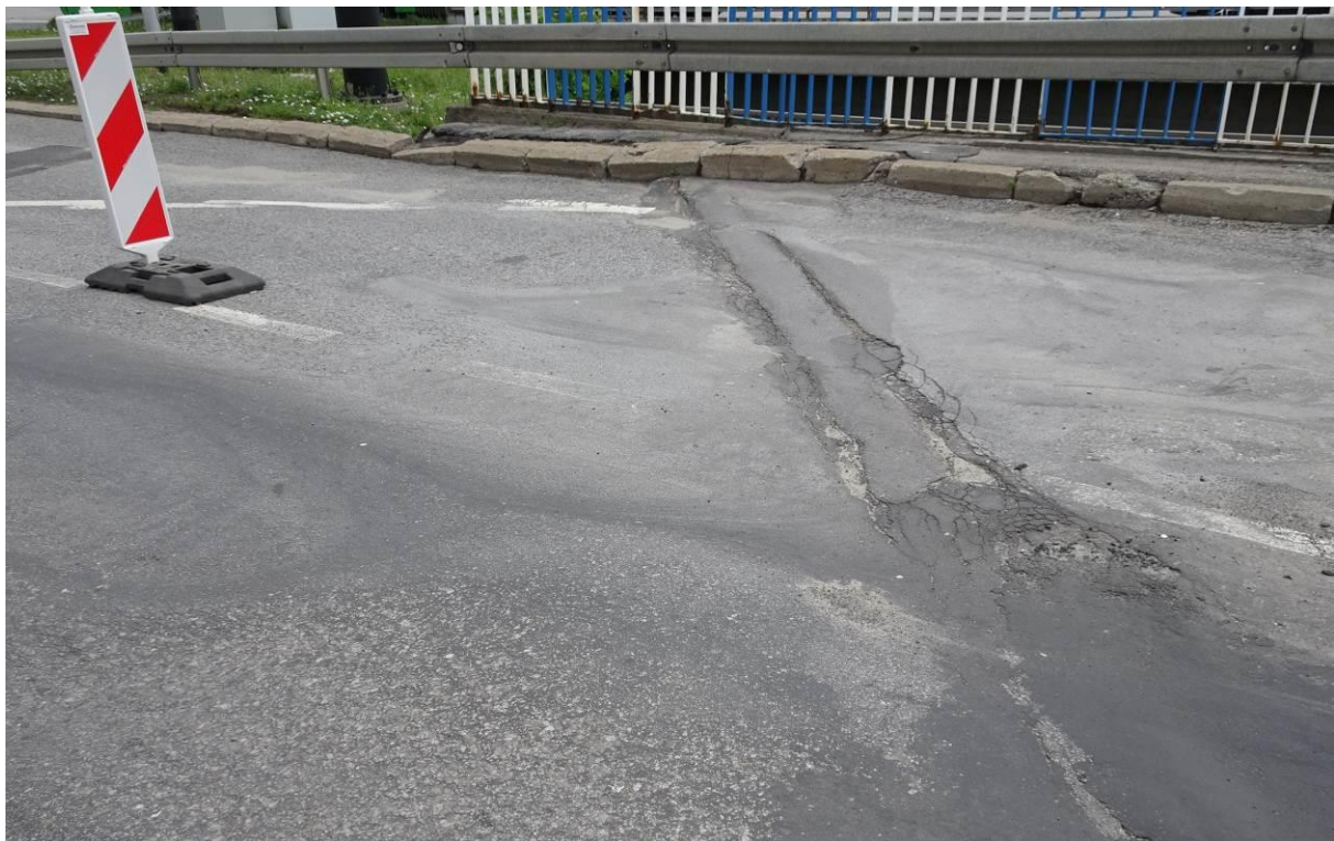
Fot. 8. Dojazd od str. Al. Solidarności. Zaniżenie nawierzchni jezdni o ok. 10 cm i deformacja krawężnika lewego spowodowana osiadaniem gruntu. Spękania i ubytki nawierzchni w obrębie dylatacji.
