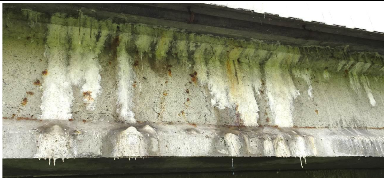
Fot. 22. Przęsło nr 2. Intensywne przecieki przez płytę pomostu wzdłuż skrajnej belki od GW, powodujące korozję betonu i zbrojenia belki.
