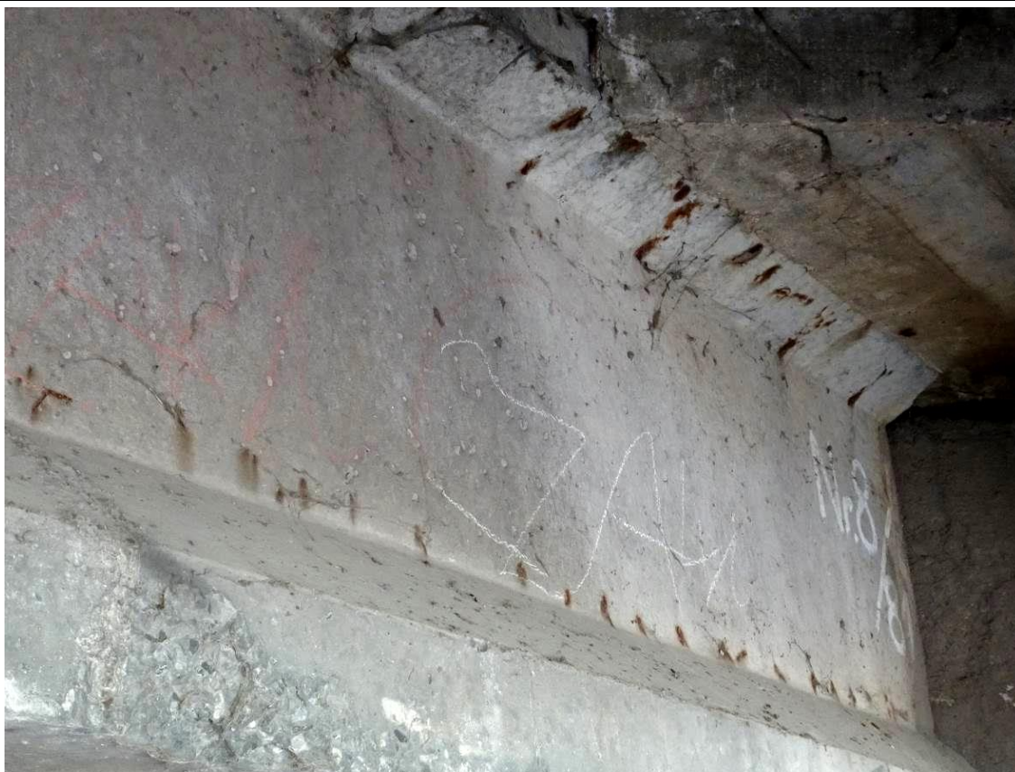
Fot. 19. Przęsło nr 1. Korozja strzemion w środku i półce górnej belki nr 9.
