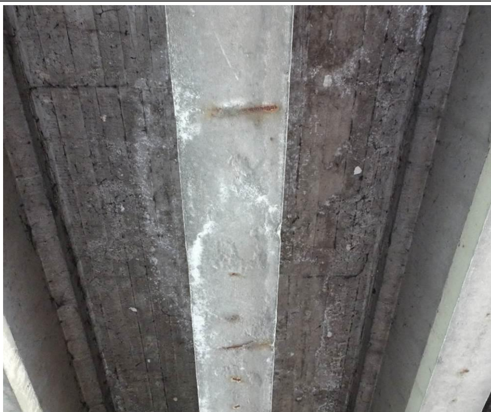
Fot. 22. Przęsło nr 1. Wykwity na płycie pomostu świadczące o uszkodzeniach izolacji
