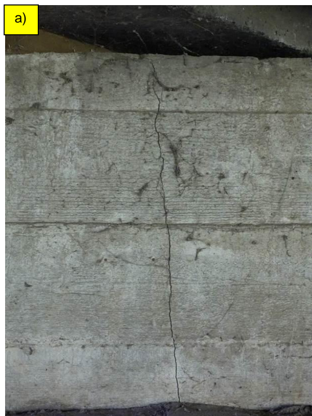
Fot. 35. Podpora P-4. Przykłady rys pionowych o rozwarości 1,6 mm w ścianie czołowej. Regularny rozstaw rys może wskazywać na ich skurczowe pochodzenie. Widoczna punktowa korozja zbrojenia.
