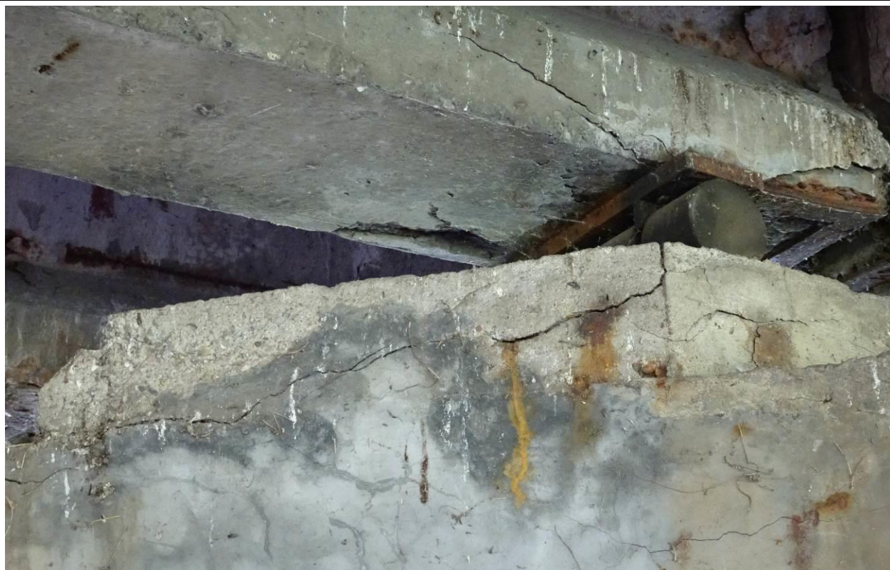
Fot. 49. Podpora P-3, widok od str. podpory nr 4. Pęknięcie betonu w ciosie podłożyskowym oraz spękania betonu w półce dolnej trzeciej belki od str. DW
