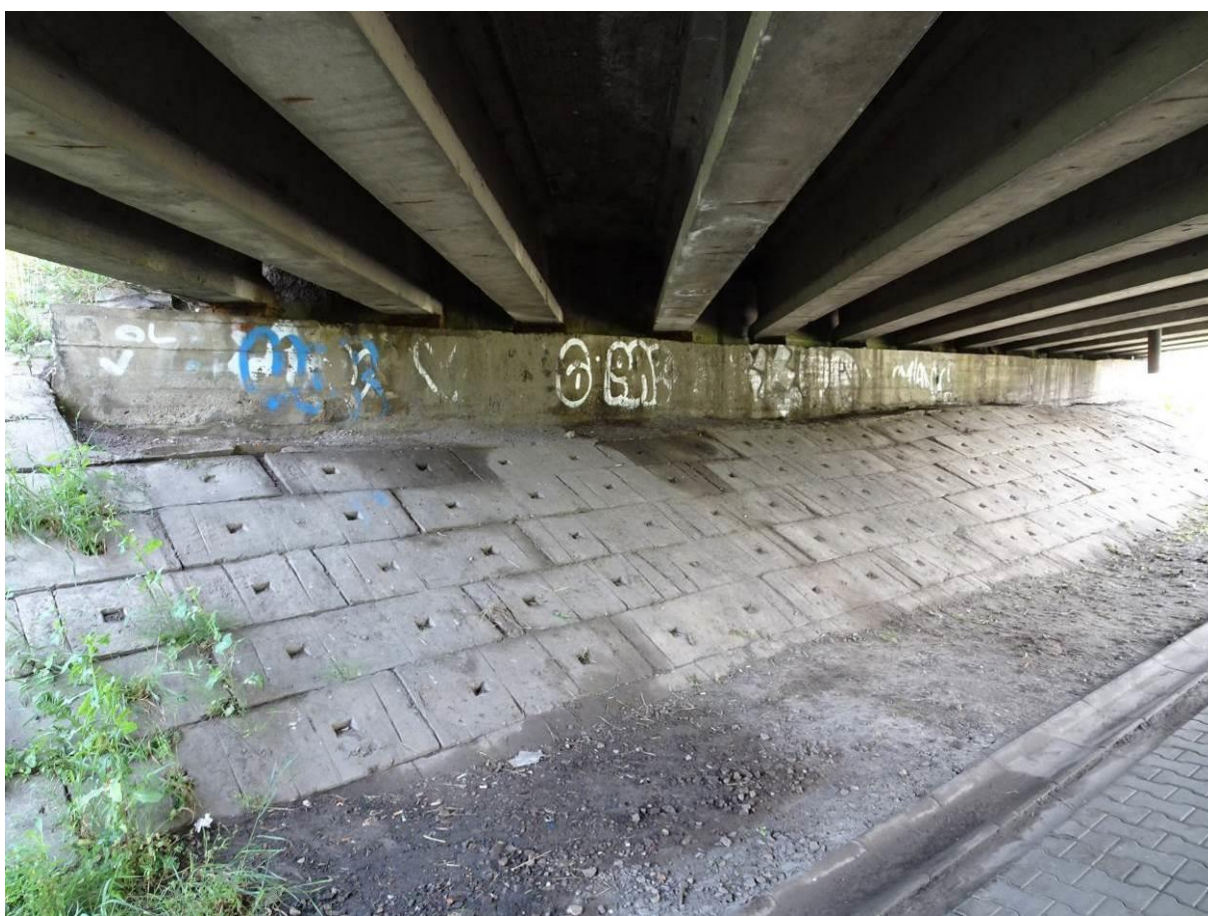
Fot. 6. Widok spodu konstrukcji przęsła oraz przyczółka lewobrzeżnego (podpora L-1)
