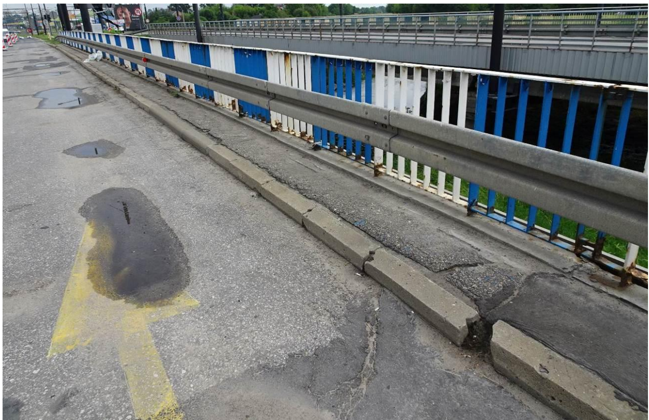
Fot. 12. Widok wzdłuż krawężnika lewostronnego. Niewielkie koleiny i deformacje nawierzchni jezdni. Ubytki i deformacje nawierzchni opaski. Korozja balustrady.
