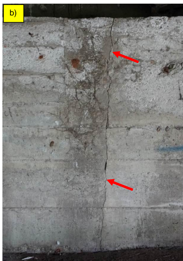
Fot. 30. Podpora P-1. Przykłady rys pionowych o rozwarości 1,0 mm w ścianie czołowej. Regularny rozstaw rys może wskazywać na ich skurczowe pochodzenie. Widoczna punktowa korozja zbrojenia.
