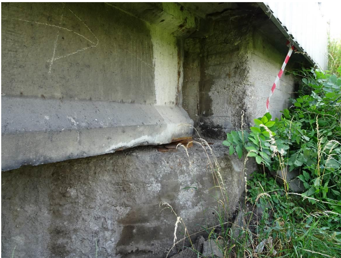
Fot. 38. Podpora L-4, widok od GW. Zanieczyszczenia i ubytki powierzchniowe betonu w ścianie czołowej i w ścianie zapleczonej spowodowane przeciekami przez dylatację. Korozja łożyska. Deformacje umocnienia stożka i bujna wegetacja zacinająca skrzydło.
