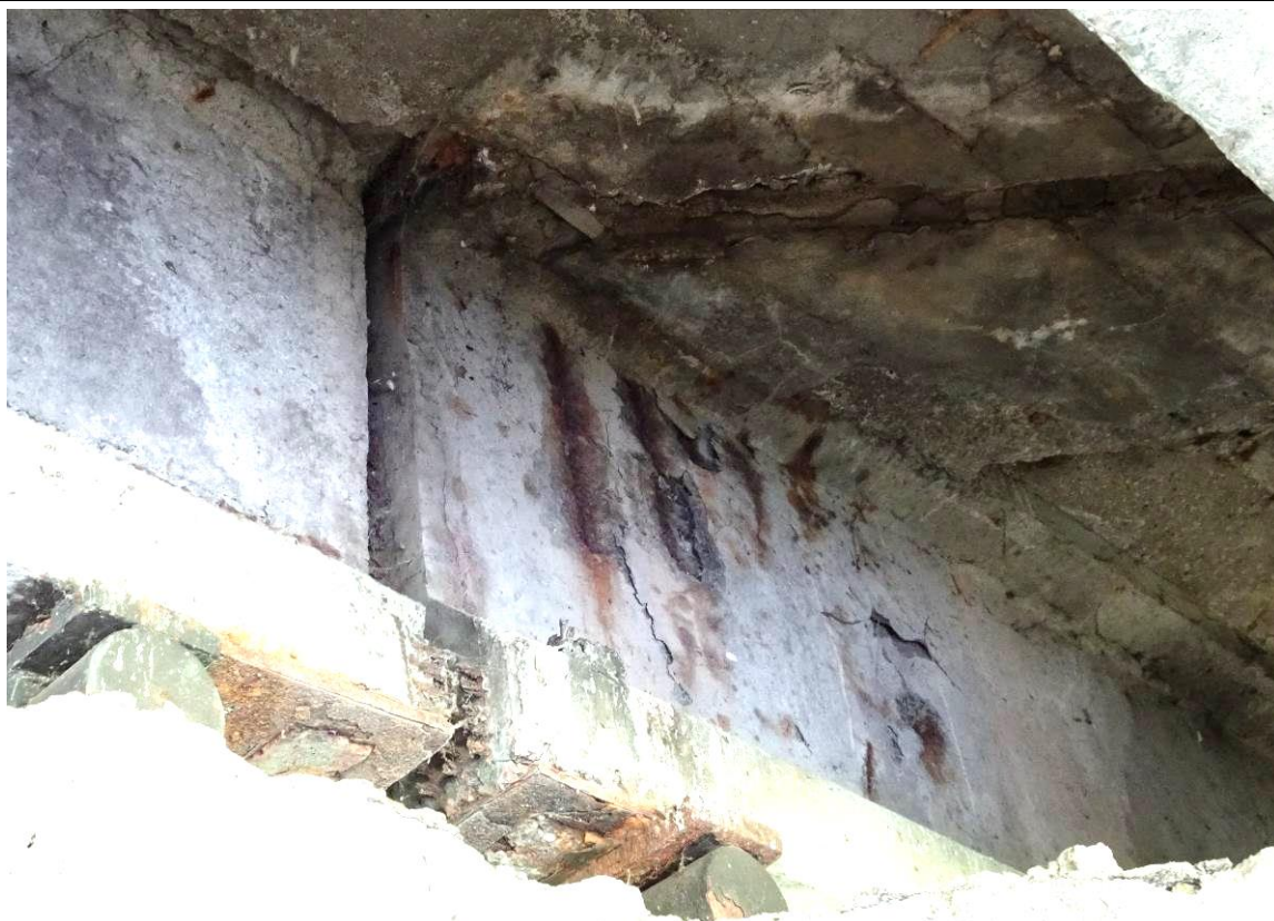
Fot. 25c. Uszkodzenia belki nr 8 nad podporą P-3. Ubytki otuliny odsłaniające skorodowane strzemiona w środku belki. Widoczne przecieki przez dylatację.
