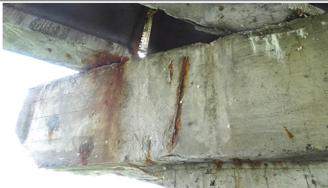
Fot. 40b. Podpora P-2, wspornik oczepu od GW, widok od str. podpory P-3. Zacieki z dylatacji powodujące intensywną korozję zbrojenia w oczepie.
