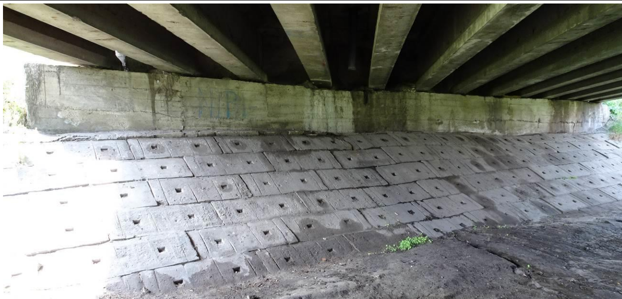
Fot. 34. Podpora L-4, widok ogólny. W ścianie czołowej korozja i ubytki powierzchniowe betonu w miejscach zacieków z dylatacji. Cztery rysy pionowe o rozwarości do 0,5 mm. W miejscach zacieków zanieczyszczenie ścianki zapleczej, ławy podłożyskowej i ściany czołowej. Szczegóły uszkodzeń pokazano na kolejnych fotografiach i na rys. 2.2.1.
