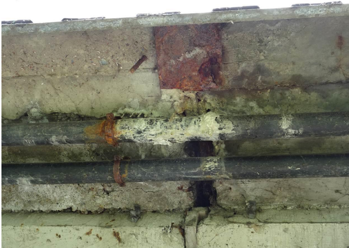
Fot. 23c. Przecieki przez dylatację nad podporą L-2 od str. DW. Widoczna korozja maskownicy dylatacji i zawiesi urządzeń obcych.
