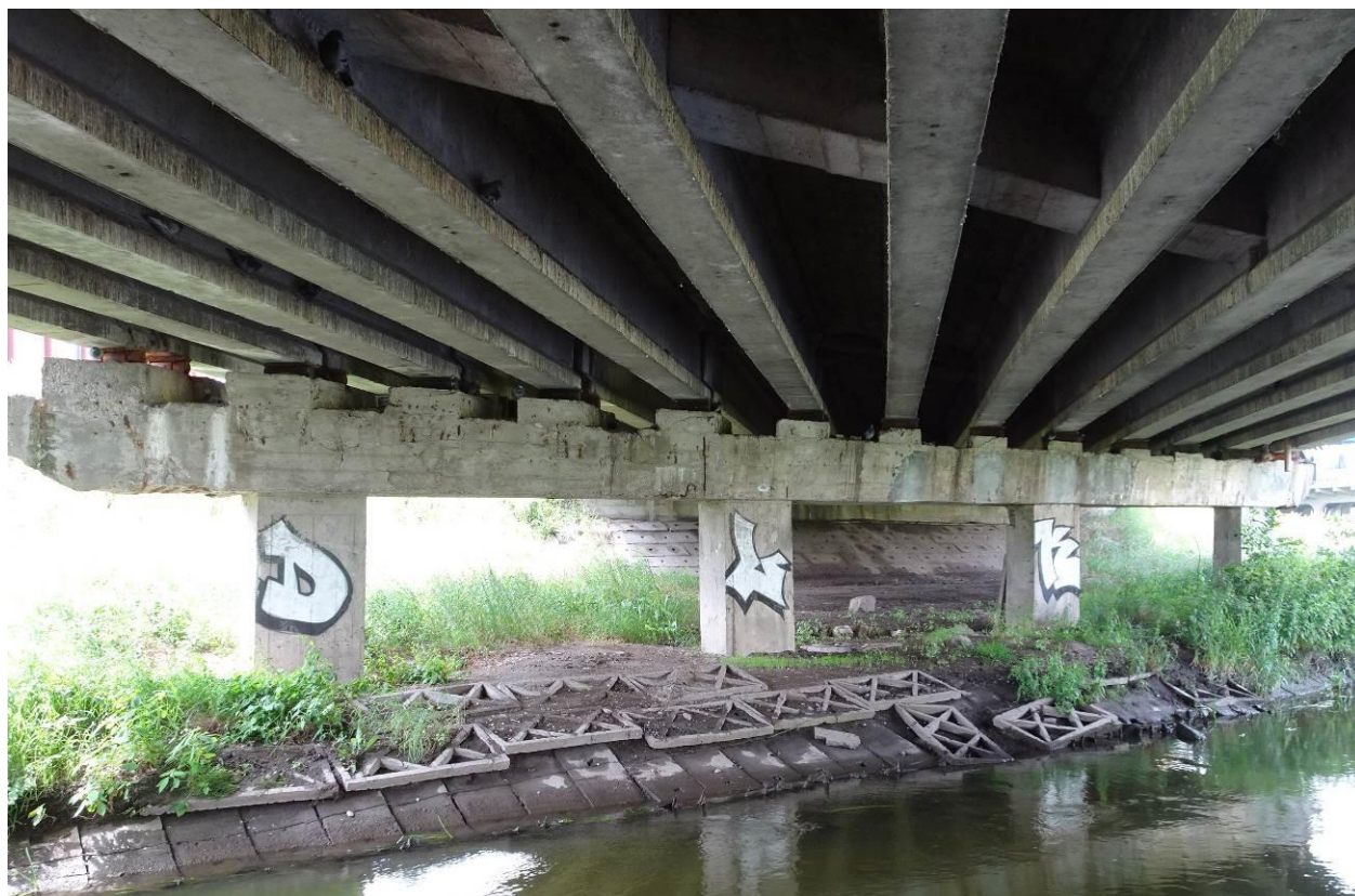
Fot. 5. Widok spodu konstrukcji przęsła oraz filara prawobrzeżnego (podpora P-3)
