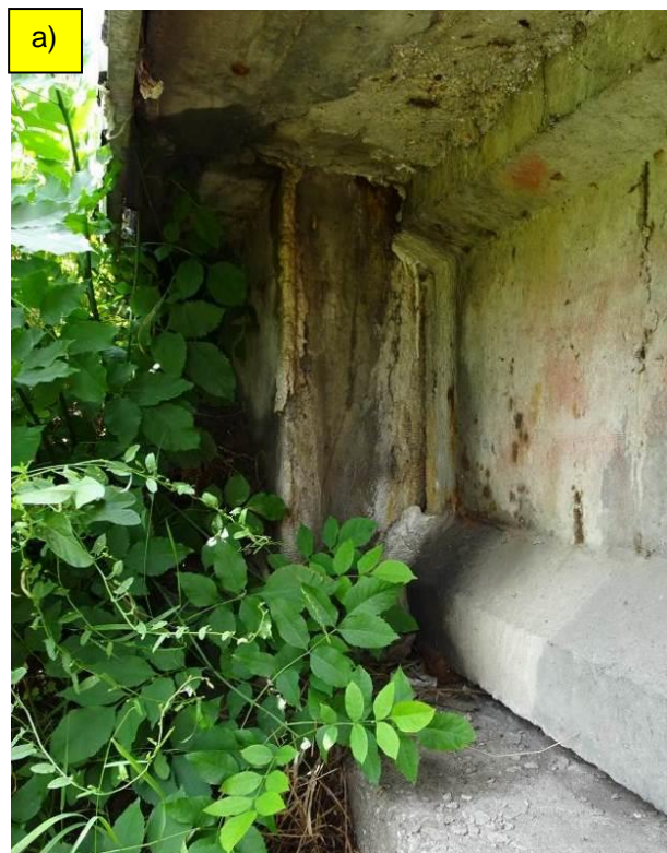
Fot. 37. Podpora P-4, widok od str. DW (fot. a) i od str. GW (fot. b). Zawilgocenie i korozja betonu w ścianie zapleczonej i w belkach spowodowane przeciekami przez dylatację. Korozja łożysk stycznych. Wegetacja roślinna na stożkach powodująca zacinienie skrzydeł.
