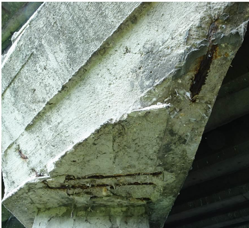
Fot. 49. Podpora L-3. Niewielkie odpryski otuliny spowodowane korozją zbrojenia na dolnej powierzchni wspornika oczepu od str. DW.
