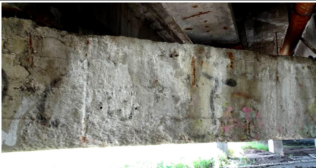
Fot. 40. Podpora L-2, widok od str. podpory P-1. Zacieki i wykwyty, korozja betonu i zbrojenia w oczipie spowodowana przeciekami przez dylatację. Uszkodzenie występuje na odcinku o długość ok. 4 mb pomiędzy słupami od str. DW.
