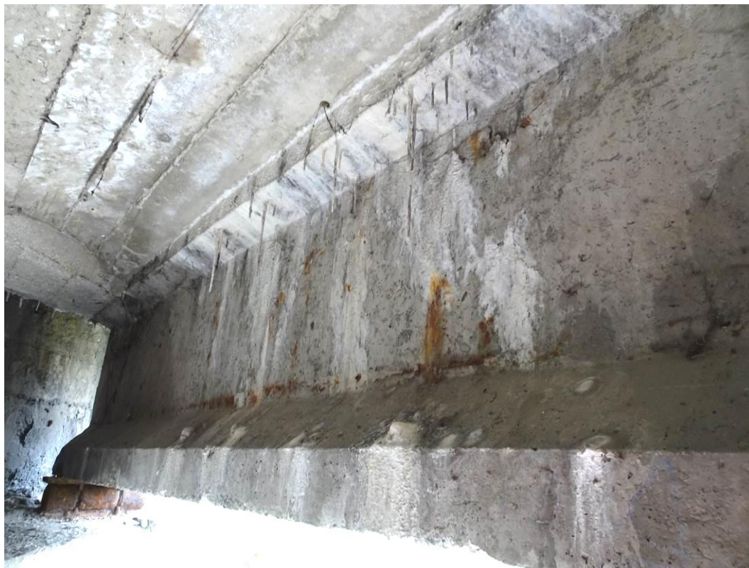
Fot. 17. Przęsło nr 1. Przecieki przez płytę pomostu powodujące zacieki na belkę nr 13 przy podporze P-1.
