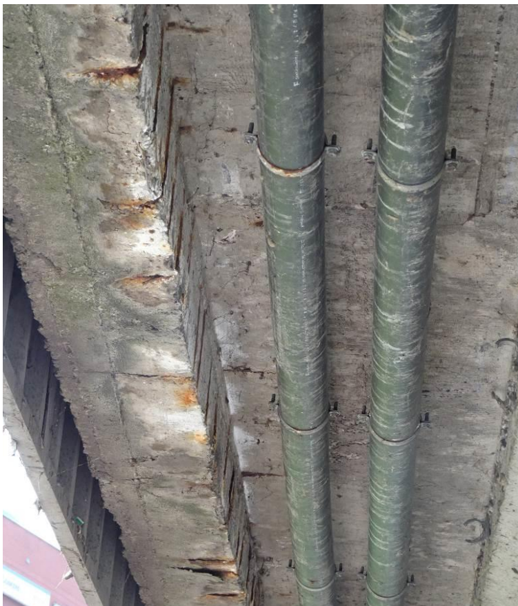
Fot. 21. Przęsło nr 1. Przecieki i korozja betonu w belce gzymsowej od DW.
