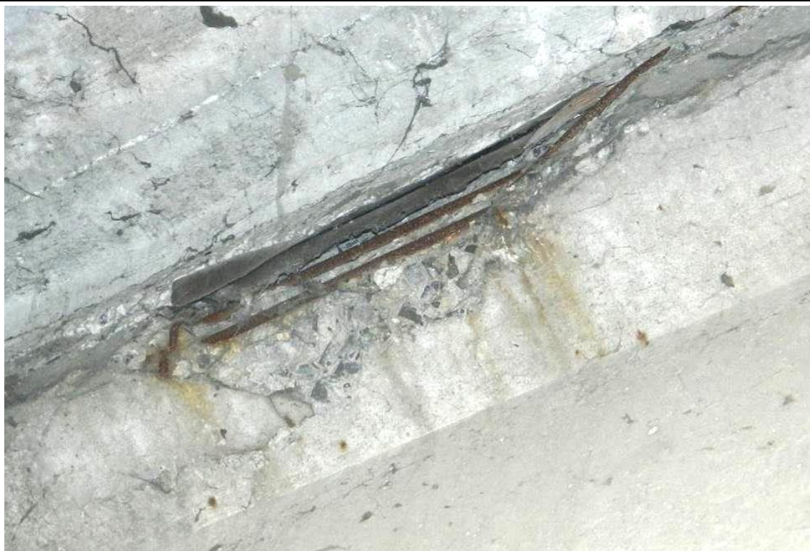
Fot. 20. Przęsło 1. Punktowy ubytek betonu w półce górnej belki nr 3 – wada wytwórcza belki. Korozja odsłoniętych prętów zbrojeniowych.
