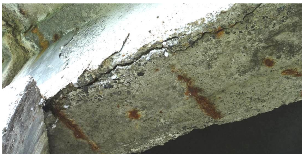
Fot. 19. Przęsło nr 1, belka skrajna od DW nad podporą P-2. Spękania i odspojenia otuliny w półce dolnej belki na długości ok. 1 mb, spowodowane intensywną korozją zbrojenia i betonu w wyniku przecieków przez dylatację.
