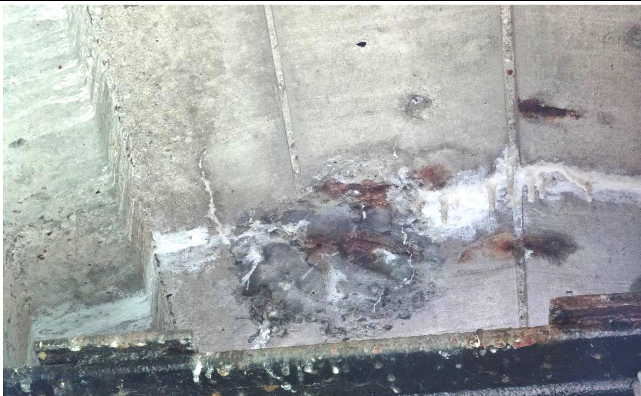
Fot. 28. Przęsło 3. Punktowy intensywny przeciek przez płytę pomostu pomiędzy belkami nr 12 i 13. Widoczna korozja zbrojenia płyty.
