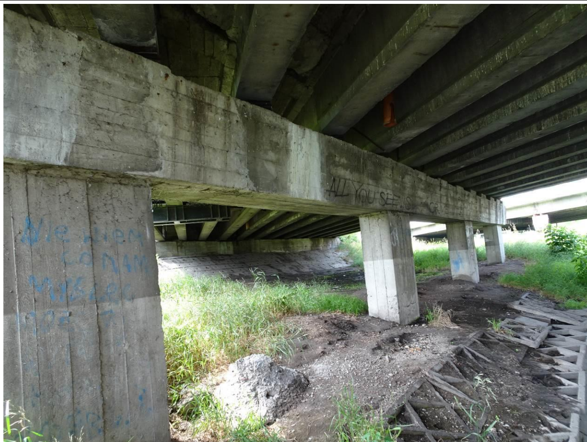
Fot. 45. Podpora L-3, widok od str. podpory L-2. Niewielkie zacieki i wykwyty na powierzchni oczepu spowodowane przeciekami przez dylatację. Deformacje umocnienia brzegu rzeki.
