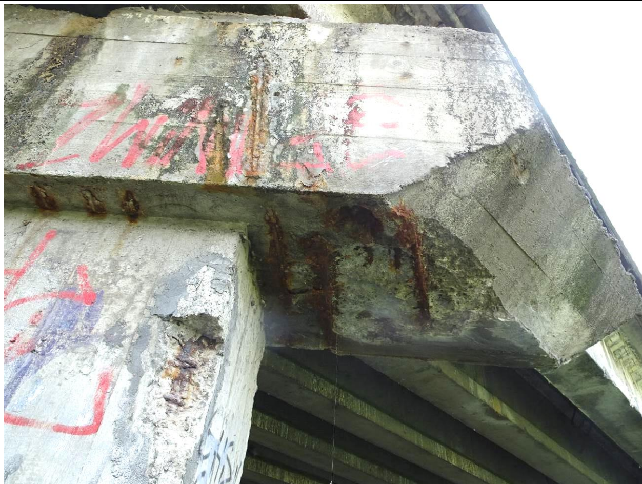
Fot. 40a. Podpora P-2, wspornik oczepu od GW, widok od str. podpory P-1. Zacieki z dylatacji powodujące intensywną korozję zbrojenia i odpryski betonu w oczepie i w słupie.
