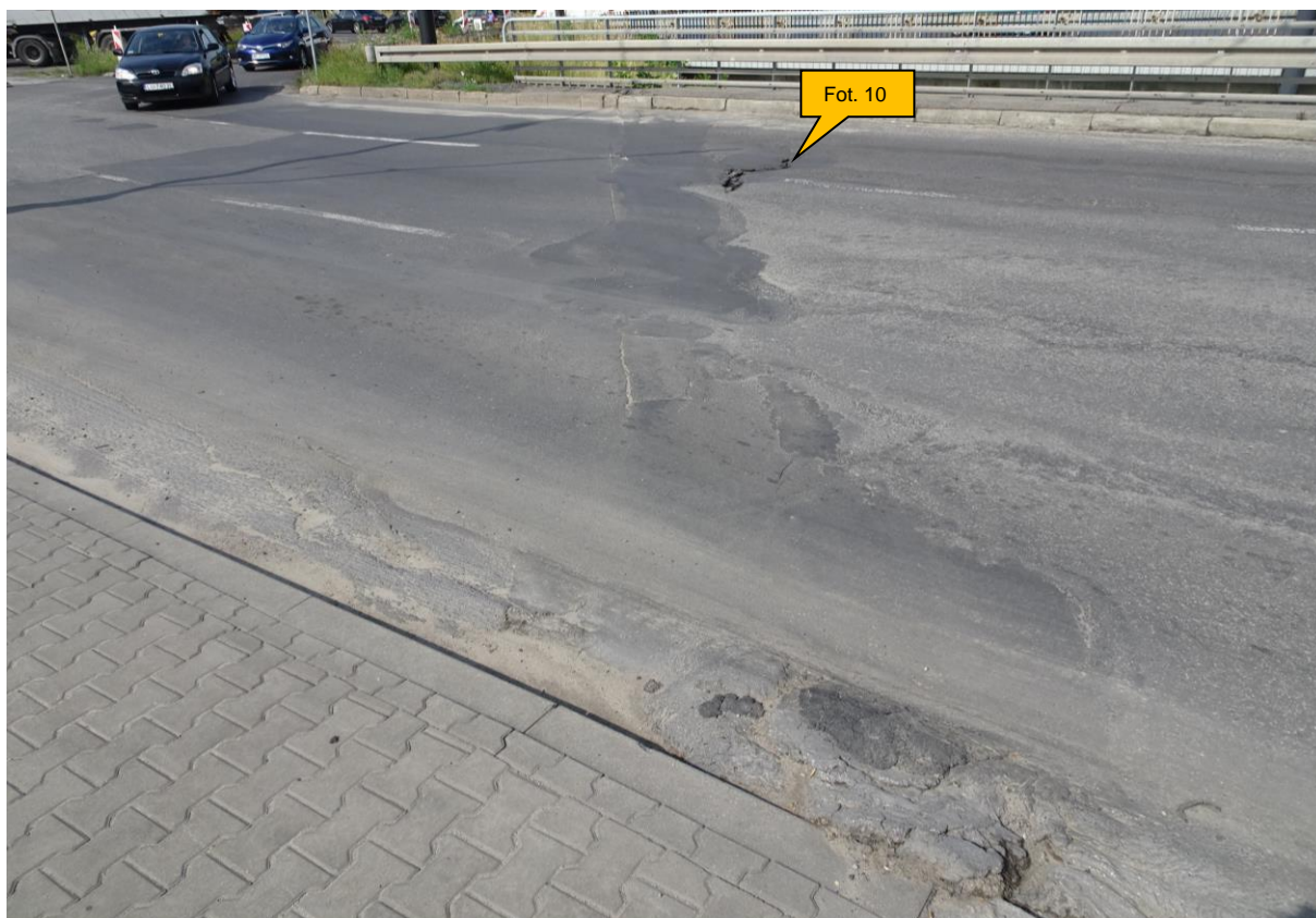
Fot. 9. Stan nawierzchni jezdni w obrębie dylatacji nad podporą L-4. Na moście i na dojeździe koleiny i deformacje nawierzchni o głębokości do ok. 5 cm (przy krawężniku do 10 cm). Lokalny ubytek nawierzchni o powierzchni ok. 1 m 2 (fot. 10). Pęknięcia nawierzchni wzdłuż dylatacji.
