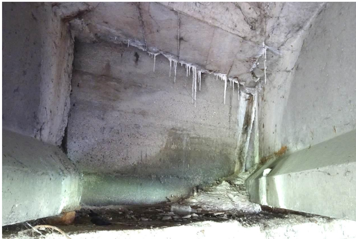
Fot. 36a. Podpora L-4. Zacieki i osady na płycie pomostu i ławie podłożyskowej spowodowane przeciekami przez dylatację.
