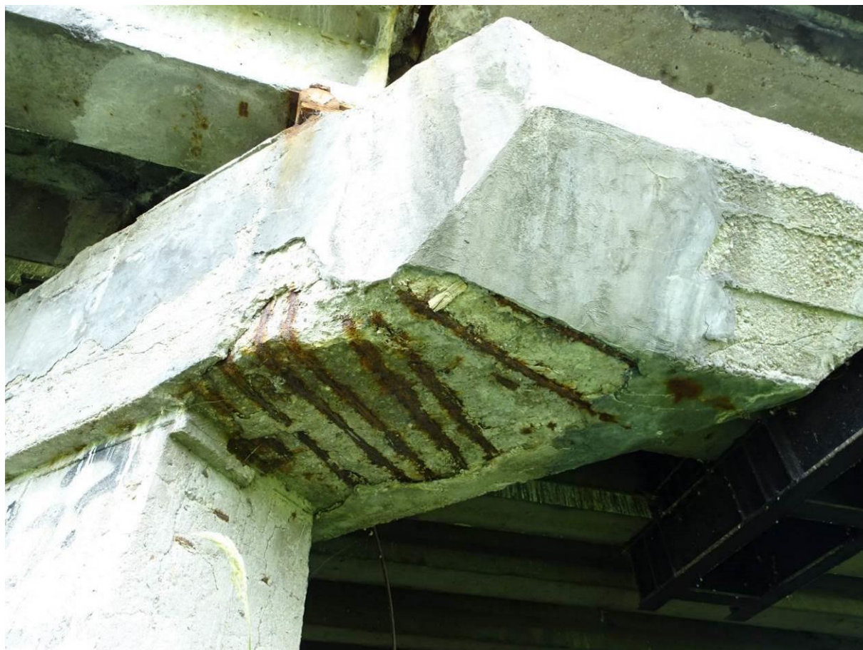
Fot. 50. Podpora P-3, wspornik oczepu od GW. Rozległe ubytki betonu odsłaniające skorodowane strzemiona. Ubytki zbrojenia sięgają 100% przekroju prętów. Uszkodzenia spowodowane zaciekaniami z dylatacji.
