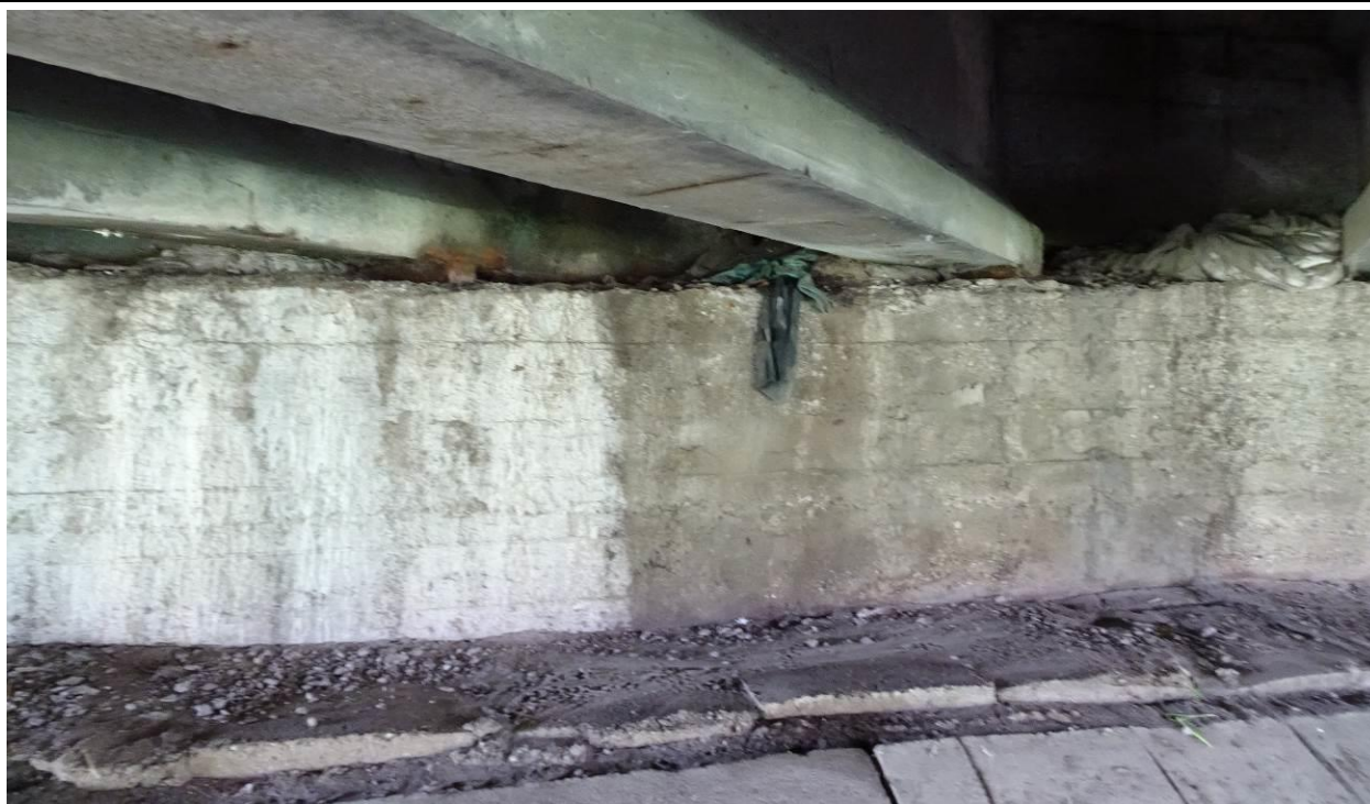
Fot. 35b. Podpora L-4. Zanieczyszczenie w środkowej części ściany czołowej i ławy podłożyskowej spowodowane przeciekami przed dylatacją. Śmieci na ławie podłożyskowej. Deformacje umocnienia skarpy.
