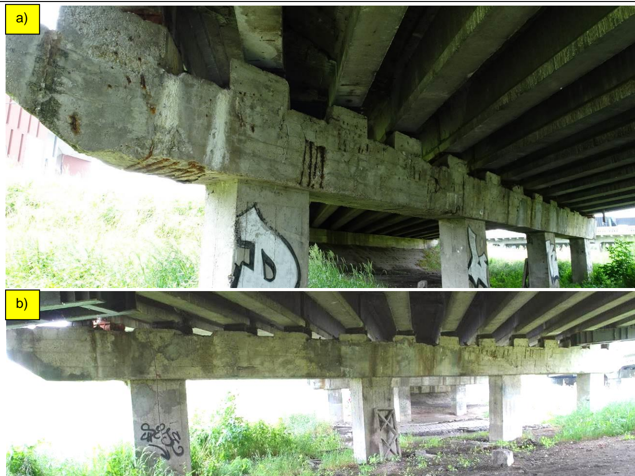
Fot. 43. Podpora P-3: a) widok od str. podpory P-2; b) widok od str. podpory P-4. Na oczepie intensywne zacieki i przecieki spowodowane nieuszczelnnością dylatacji. W miejscach zacieków intensywna korozja betonu i zbrojenia oraz spękania i odpryski otuliny. Zarysowania i odpryski otuliny również we wszystkich słupach. Szczegóły uszkodzeń na kolejnych fotografiach na rys. 2.2.3.
