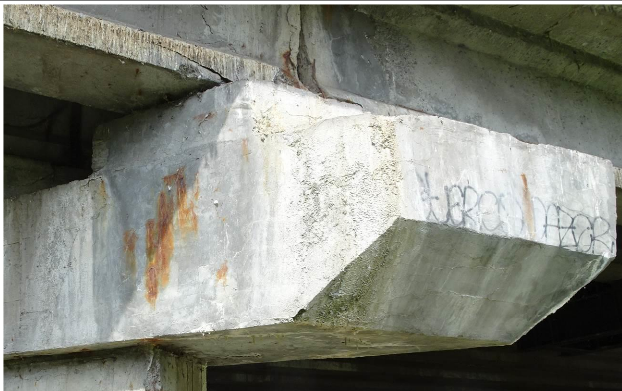
Fot. 39b. Podpora P-2, wspornik oczepu od DW, widok od str. podpory P-3. Przecieki przez oczep powodujące intensywną korozję betonu i zbrojenia. Zarysowania i odpryski otuliny betonowej. Widoczne uszkodzenia skrajnej belki (por. fot. 18, 19).
