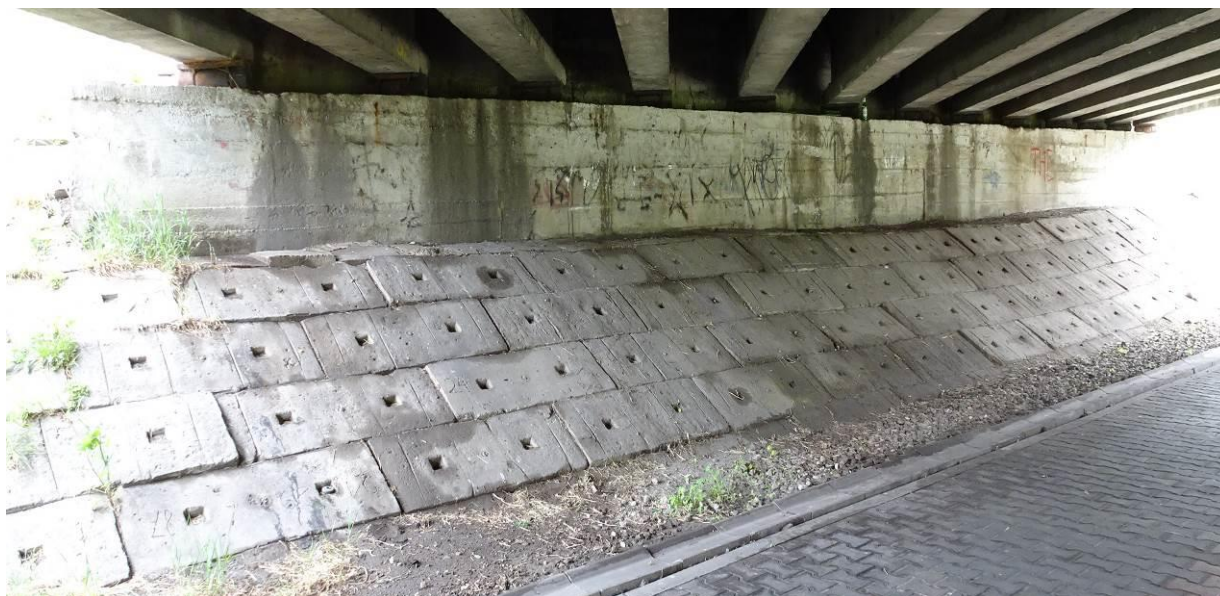
Fot. 29. Podpora P-1, widok ogólny. W ścianie czołowej pięć rys pionowych o rozwarości do 1,0 mm. Na ścianie zapleczej, ławie podłożyskowej i ścianie czołowej osady i przebarwienia betonu w wyniku przecieków przez dylatację. Lokalna korozja betonu i zbrojenia w ścianie czołowej. Szczegóły uszkodzeń na kolejnych fotografiach i na rys. 2.2.1.
