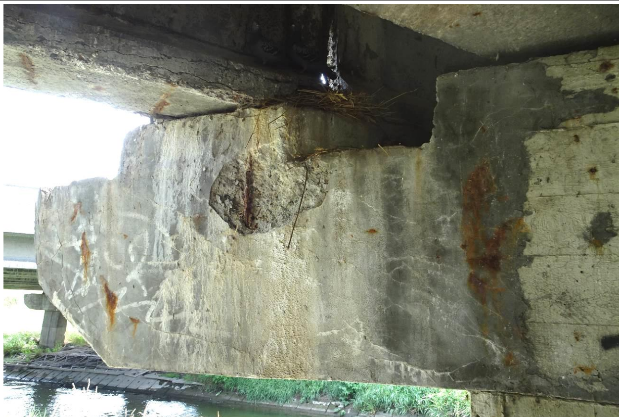
Fot. 39a. Podpora P-2, wspornik oczepu od DW, widok od str. podpory P-1. Przecieki przez oczep powodujące intensywną korozję betonu i zbrojenia. Zarysowania i odpryski otuliny betonowej. Widoczne uszkodzenia skrajnej belki (por. fot. 18, 19).
