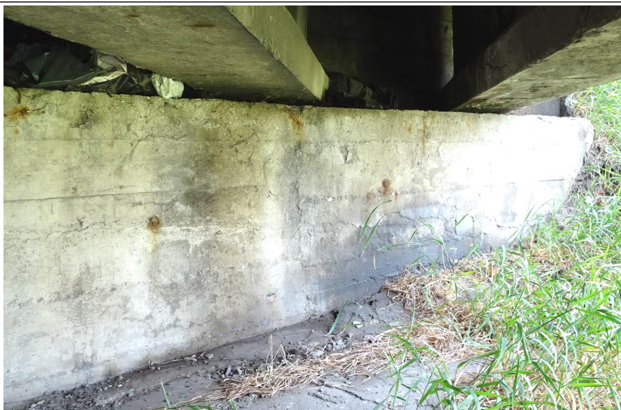
Fot. 36c. Podpora P-4. Zacieki i wykwyty w ścianie czołowej od str. GW spowodowane zaciekami z rury spustowej. Punktowa korozja zbrojenia.
