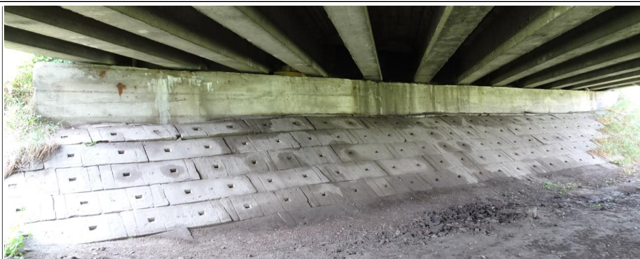
Fot. 34. Podpora P-4, widok ogólny. W ścianie czołowej cztery rysy pionowe o rozwarości do 1,6 mm, przechodzące na ścianki zapleczne. Na ścianie zapleczej, ławie podłożyskowej i ścianie czołowej osady i przebarwienia betonu w wyniku przecieków przez dylatację. Lokalna korozja betonu i zbrojenia w ścianie czołowej. Szczegóły uszkodzeń na kolejnych fotografiach i na rys. 2.2.1.
