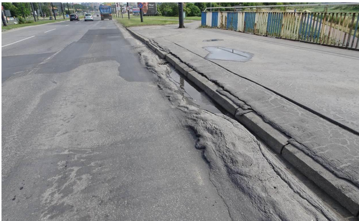
Fot. 12. Szczegół uszkodzeń nawierzchni na skrajnym pasie ruchu od DW. Wysokość garbu sięga lokalnie ponad 10 cm i uniemożliwia spływ wody z jezdni do wpustów.
