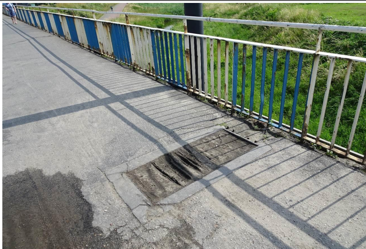
Fot. 16. Widok chodnika od DW w przejściu 3. Zaniżona pokrywa studzienki rewizyjnej, pokryta warstwą gruntu. Korozja balustrady.
