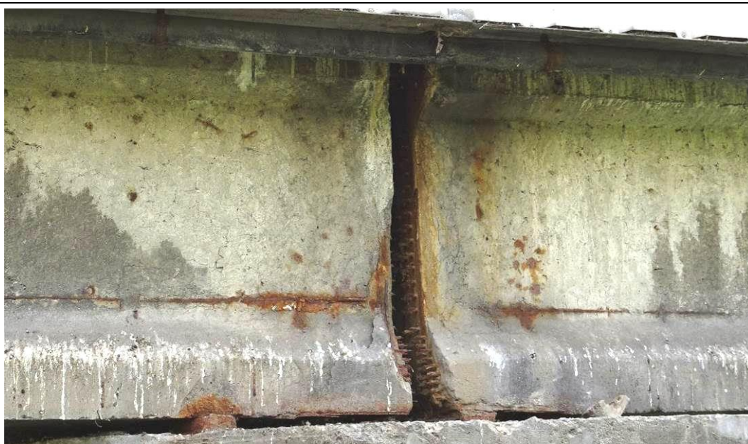
Fot. 20. Belki skrajne od GW nad podporą P-2. Korozja zbrojenia i betonu w następstwie przecieków przez dylatację. Korozja łożysk stykowych.
