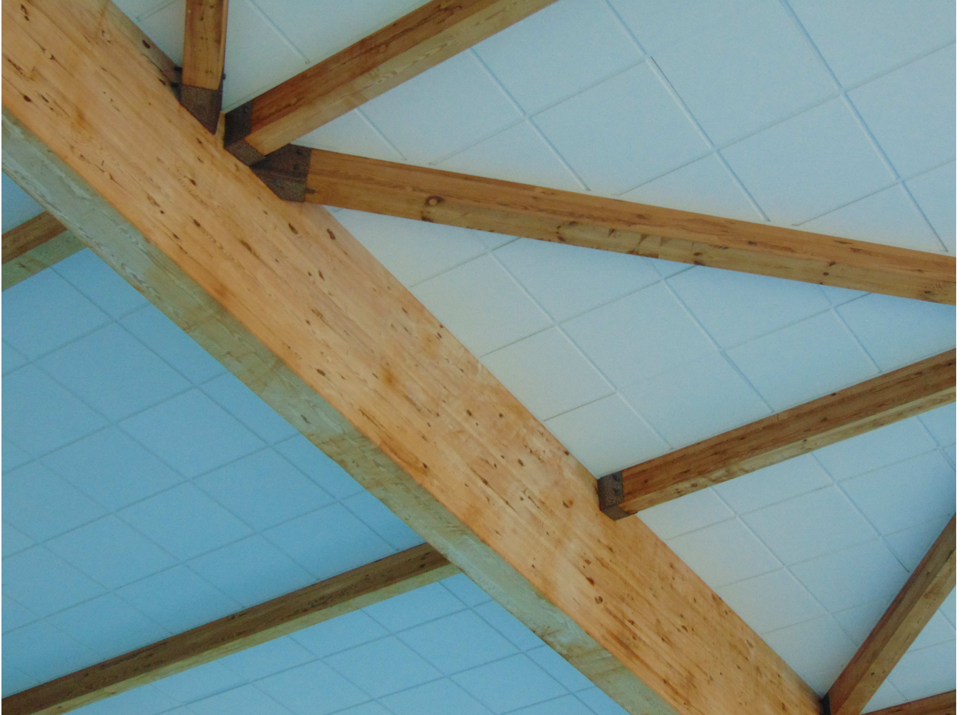
Widok skorodowanych łączników, zacieków na belkach, wyblaknięć
