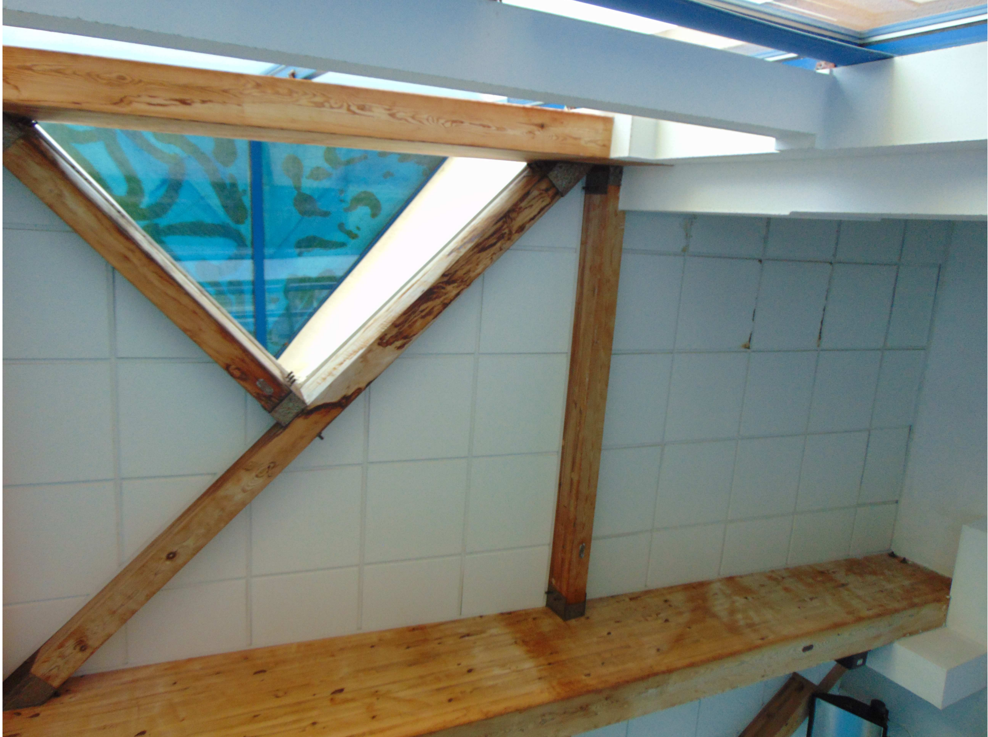
Widok zacieków i wyblaknięć na belkach
