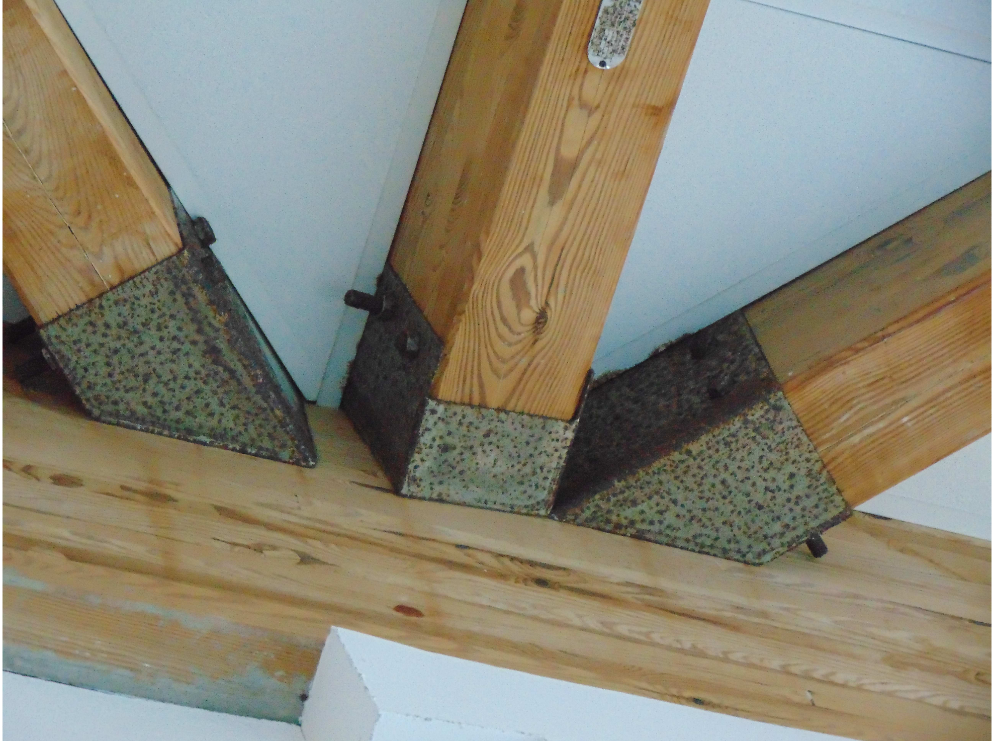
Widok skorodowanych łączników, zacieków na belkach
