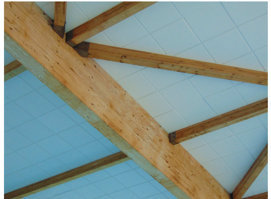
Widok skorodowanych łączników, zacieków na belkach, wyblaknięć
