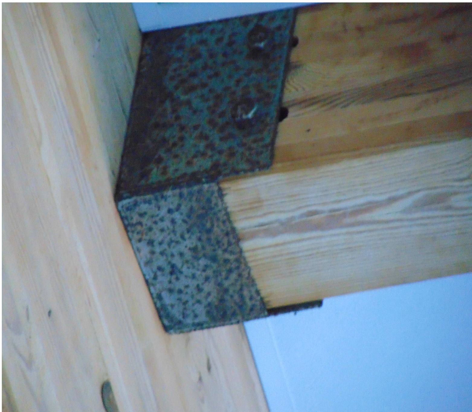
Skorodowany łącznik, przebarwienia belki
