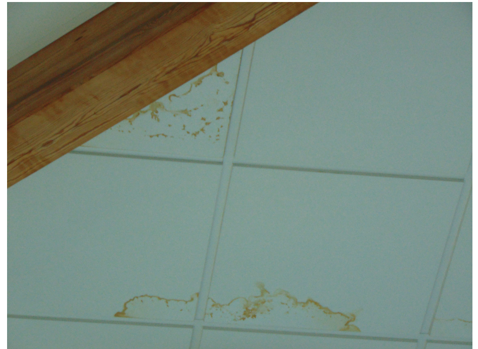
Widok zacieków na belkach, na kasetonach stropu podwieszonego
