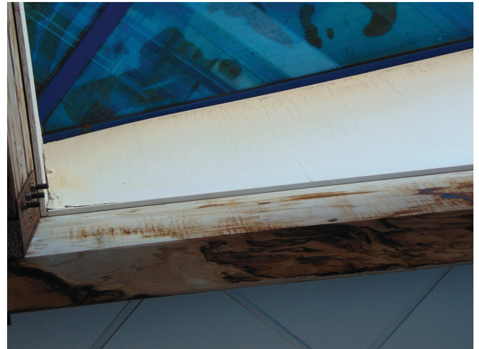
Widok zacieków na belkach i płytach okładzinowych (świetlik)
