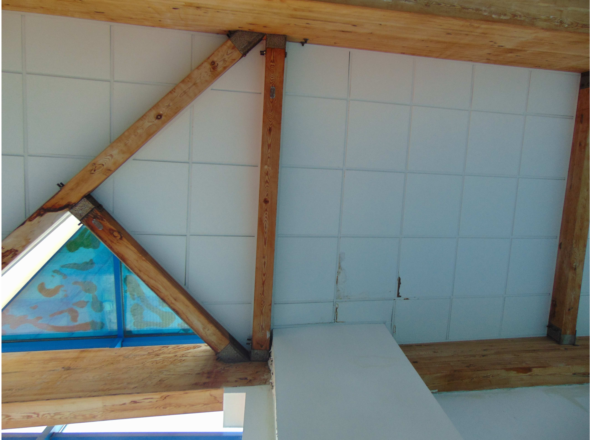
Widok świetlika, zacieków na belkach i kasetonach stropu
