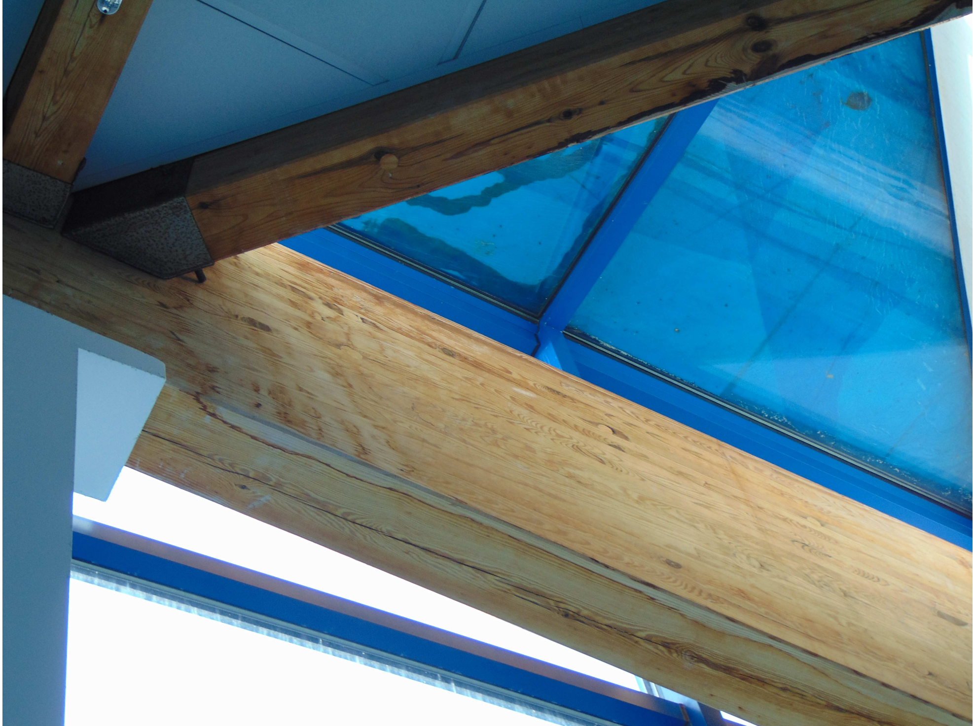
Widok świetlika, zacieków na belkach
