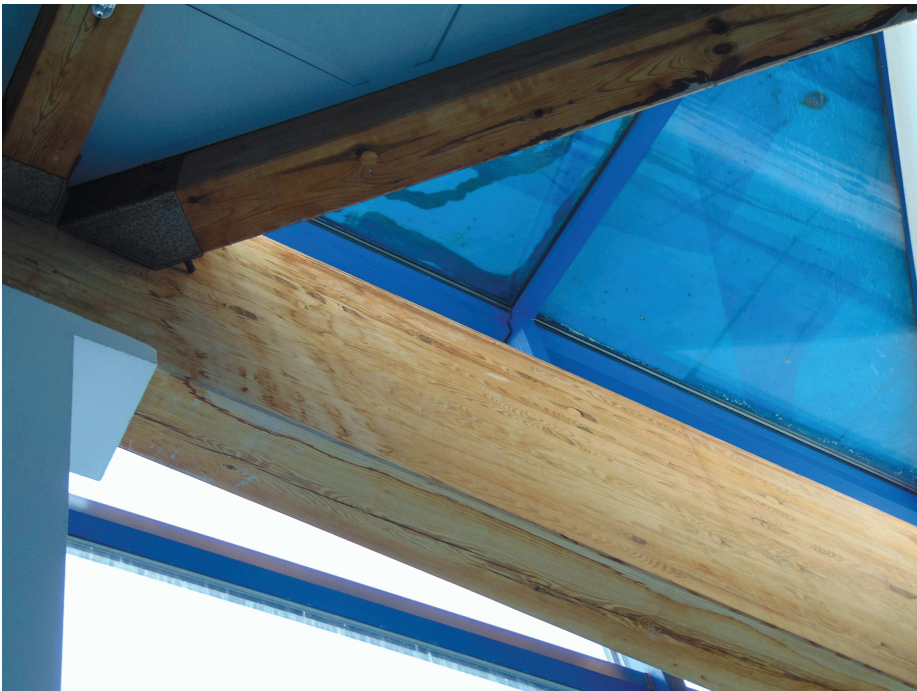
Widok świetlika, zacieków na belkach
