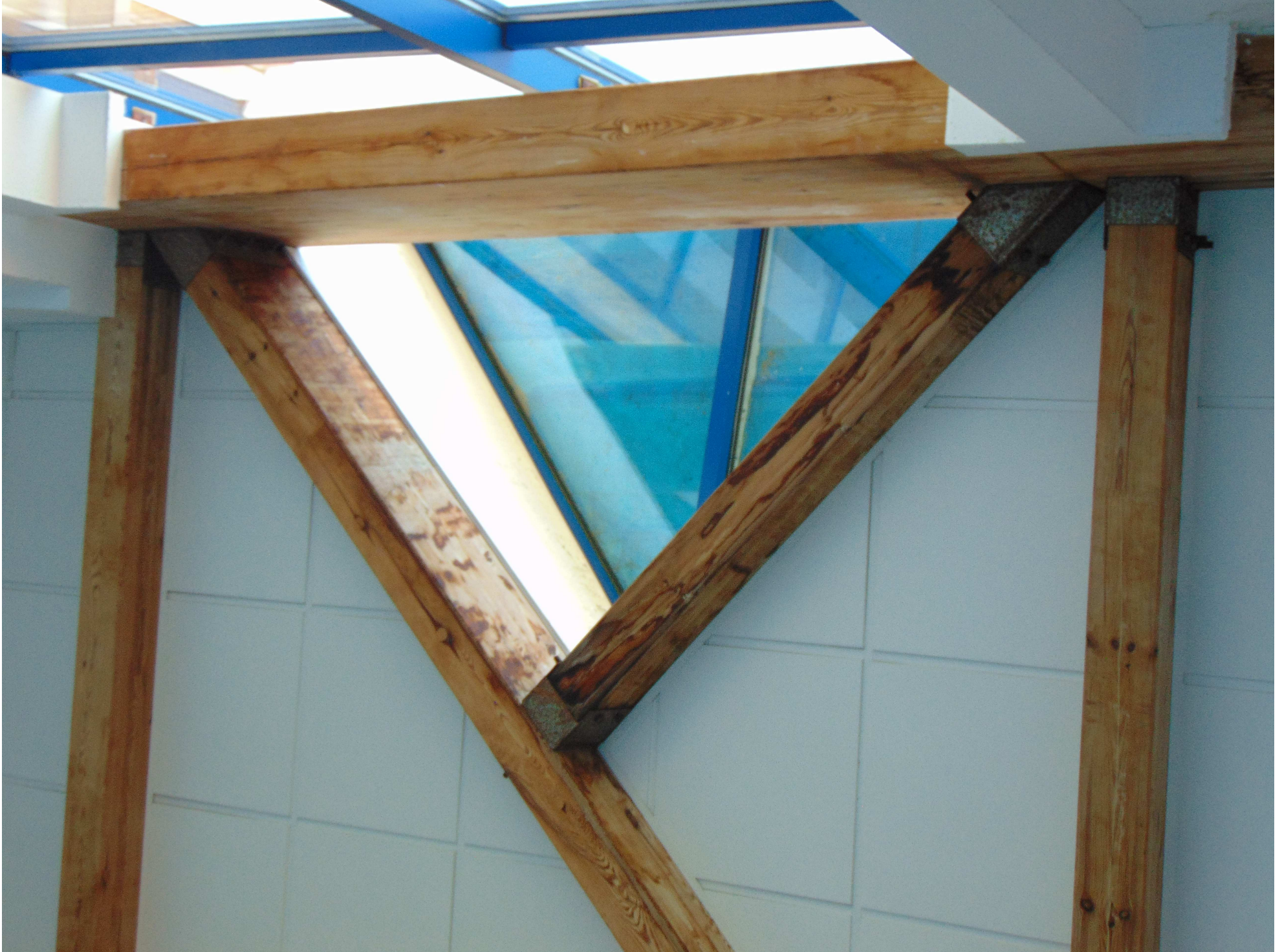
Widok zacieków i wyblaknięć na belkach, korozja łączników (światlik)
