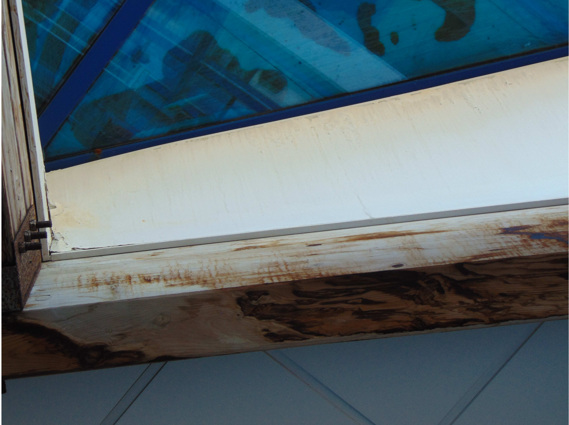
Widok zacieków na belkach i płytach okładzinowych (światlik)
