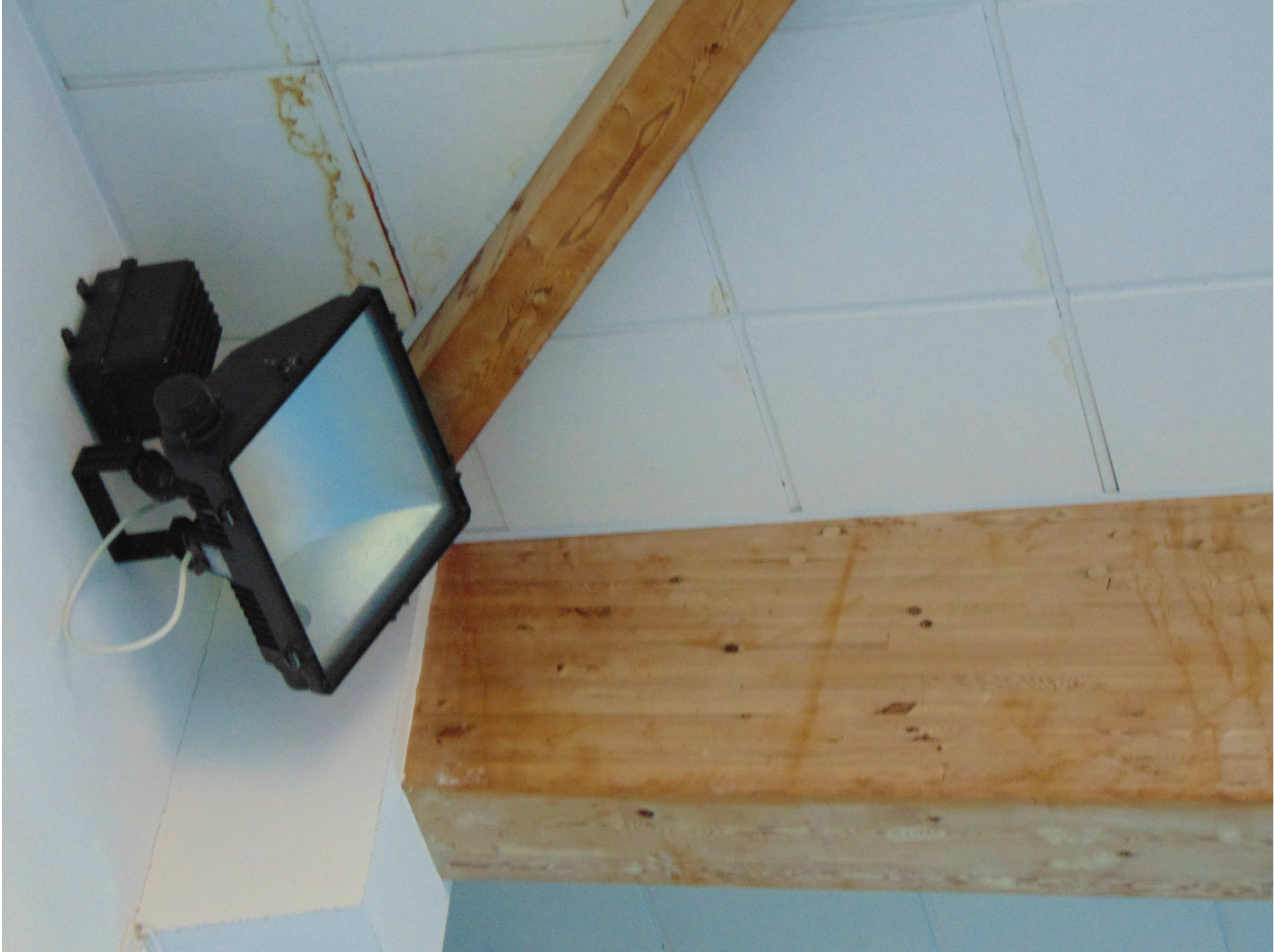
Widok zacieków i wyblaknięć na belkach, zacieki na stropie podwieszonym
