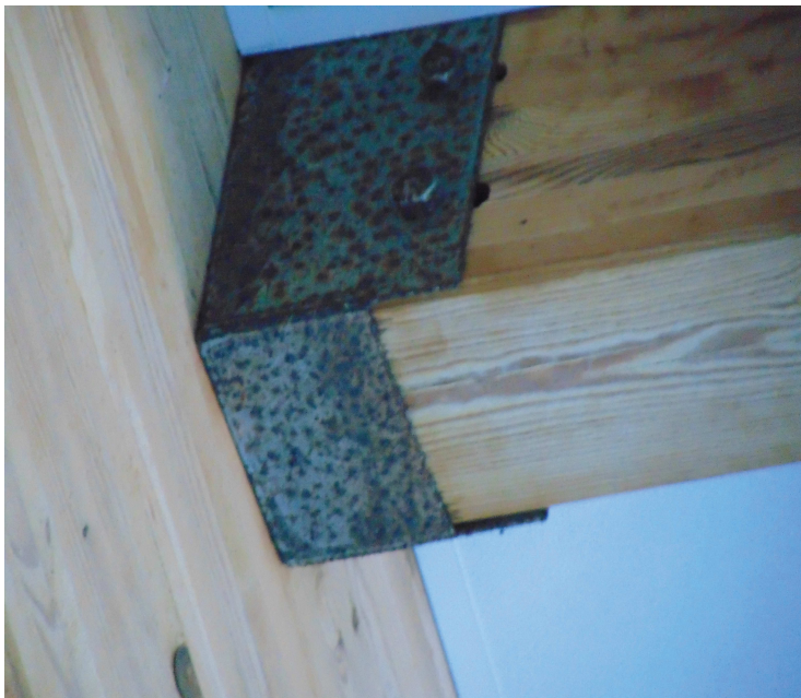
Skorodowany łącznik, przebarwienia belki
