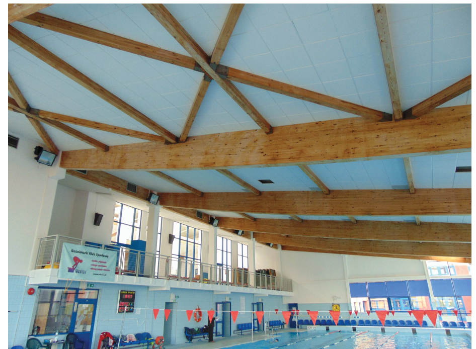
Widok basenu, widoczne zacieki i wyblaknięcia na podciągach
