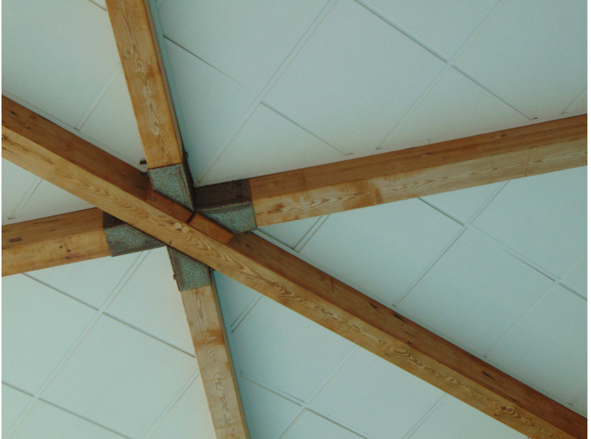
Widok skorodowanych łączników, zacieków na belkach
