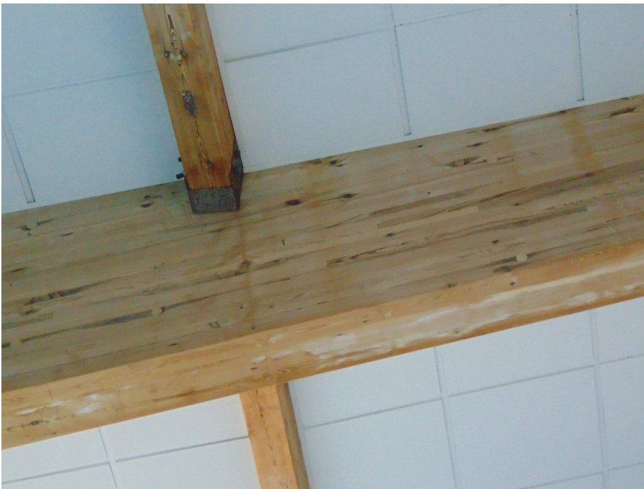
Widok skorodowanych łączników, zacieków na belkach, wyblaknięć
