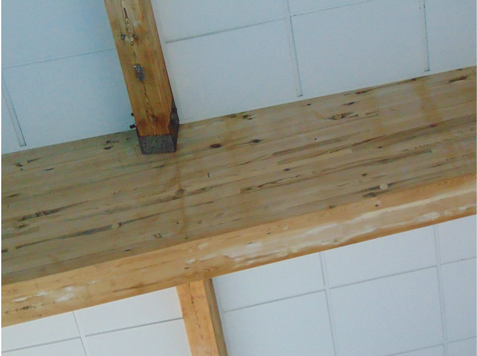
Widok skorodowanych łączników, zacieków na belkach, wyblaknięć
