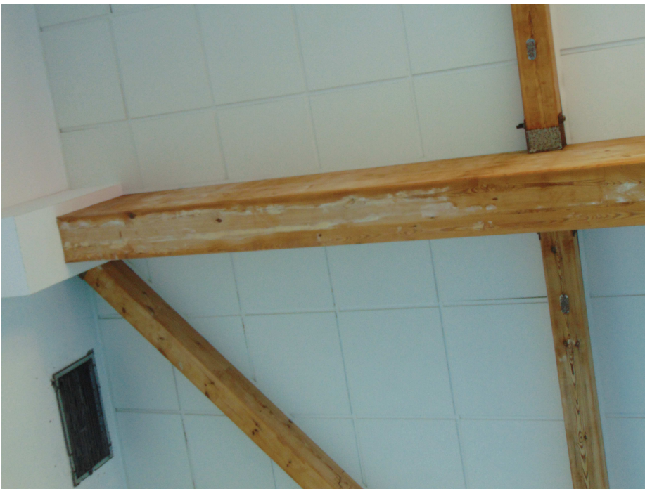
Widok zacieków i wyblaknięć na belkach, korozja łączników
