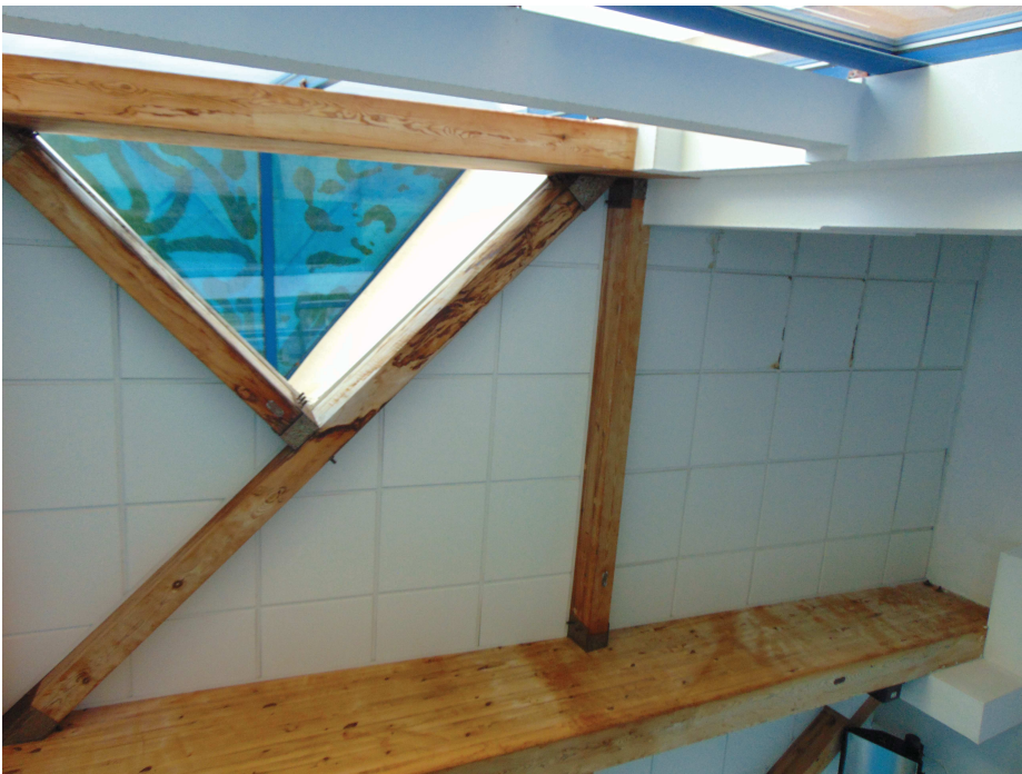
Widok zacieków i wyblaknięć na belkach
