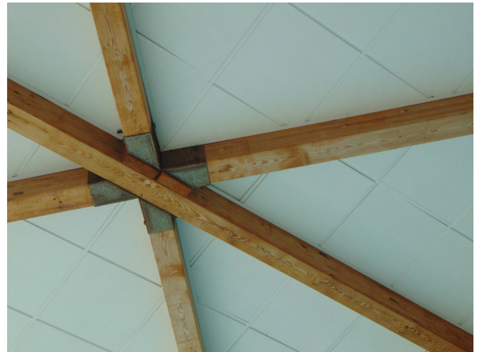
Widok skorodowanych łączników, zacieków na belkach
