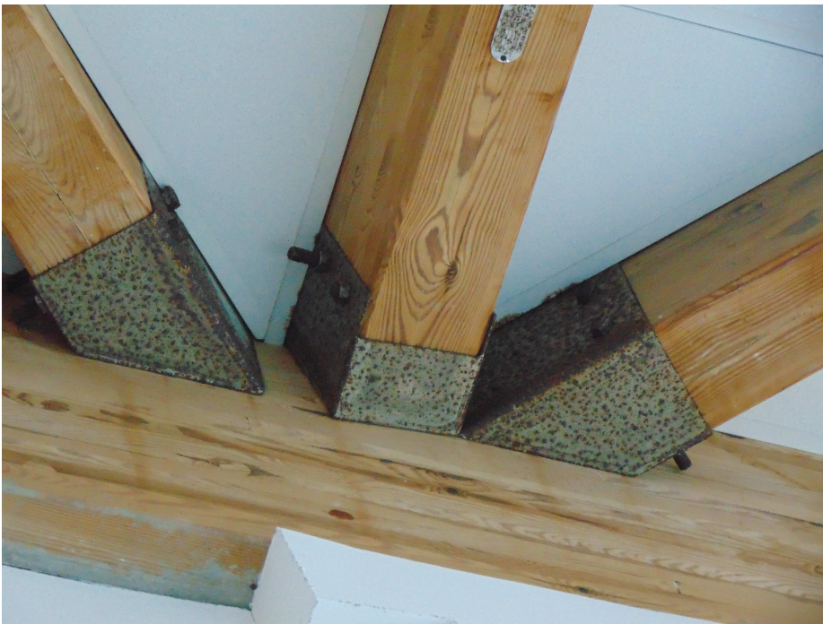
Widok skorodowanych łączników, zacieków na belkach
