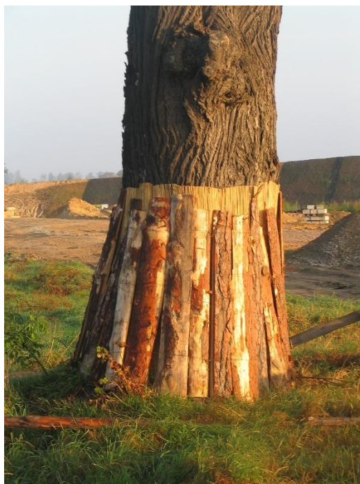
Rysunek 21 Przykładowy sposób zabezpieczenia drzew przed uszkodzeniami
