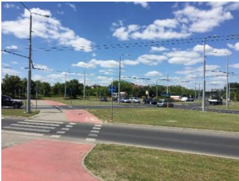
Rejon planowanej budowy estakady nad skrzyżowaniem ulic Krochmalnej i Diamentowej
