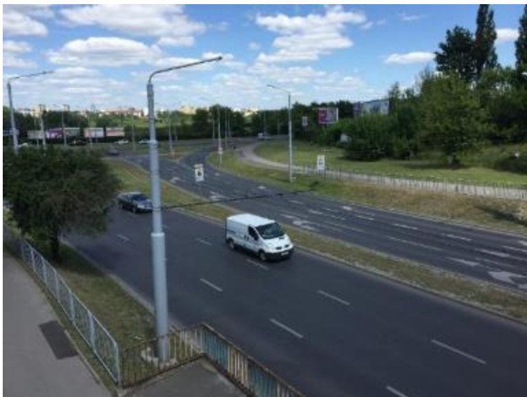
Rejon ulicy Diamentowej - odcinek ul. Diamentowej – podlegający przebudowie od skrzyżowania z ul. Krochmalną w kierunku wiaduktu kolejowego
