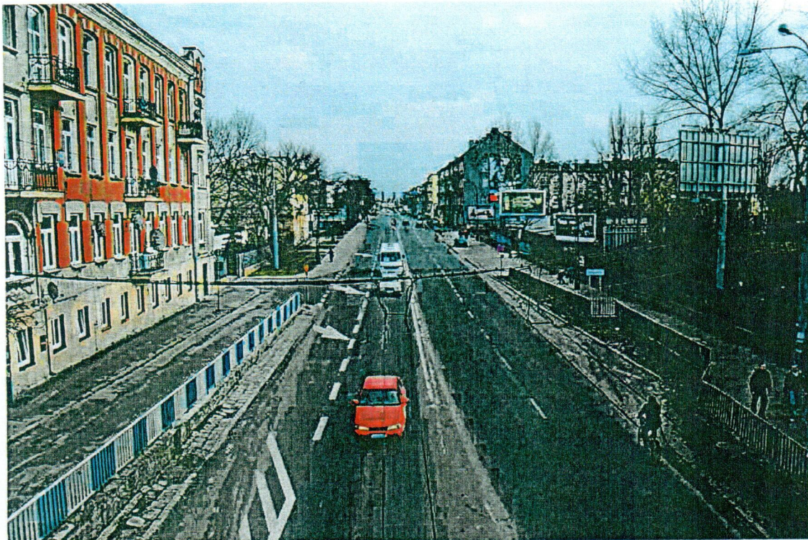
Widok z wiaduktu w stronę dzielnicy Dziesiąta.
